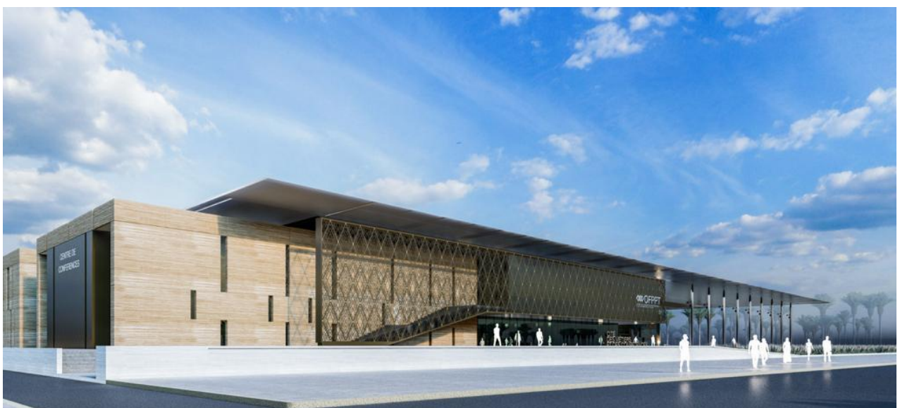
Vue sur l'entrée principale de la CMC Laâyoune-Sakia El Hamra
