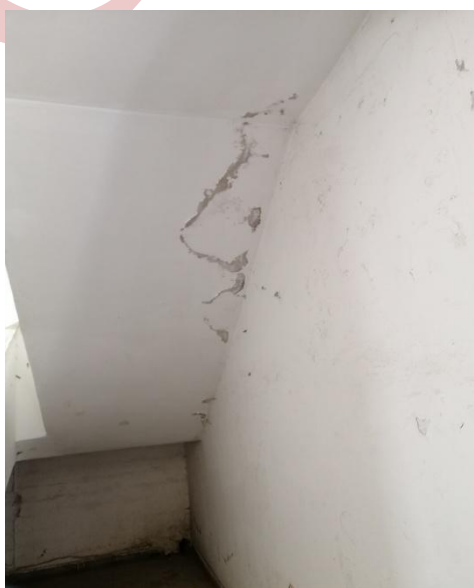
Figure 47,48,49,50 et 51 : Apparition des traces d'humidité et écaillage de la peinture.
