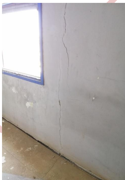
Figure 24,25,25,27 et 28 : Dégradation des enduits, Apparition des traces d'humidité et écaillage de la peinture.
