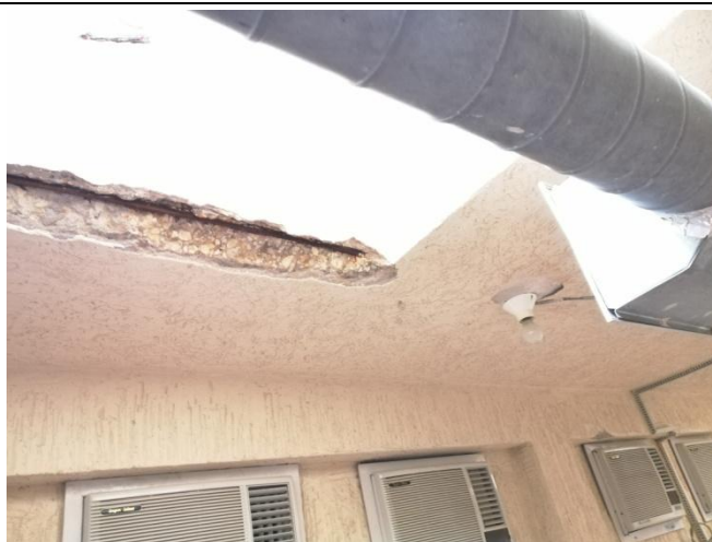
Figure 80: Apparition des armatures avec apparition de corrosion.
