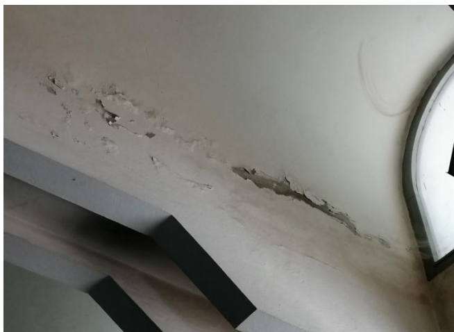
Figure 63,64,65 et 66 : Apparition des traces d'humidité et écaillage de la peinture.
