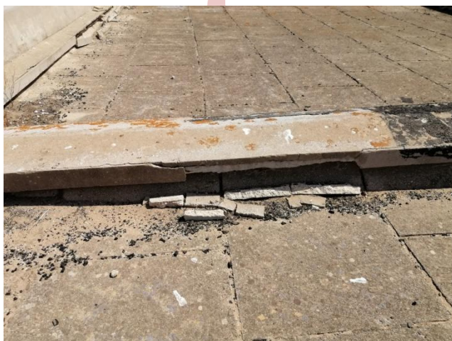
Figure 112 et 113 : Dégradation de système d'étanchéité, et des acrotères au niveau des ateliers.
