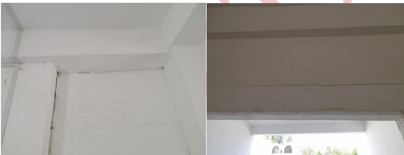
Figure 52,53,54,55 et 56 : Apparition des fissures horizontales et verticales profond.
