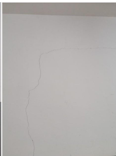
Figure 99,100,101 et 102 : Apparition des fissurations au niveau des enduits.
