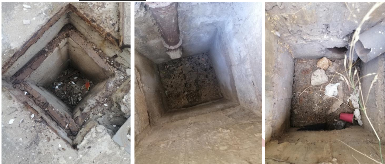
Figure 173, 174 et 175 : Conduites et regards d'assainissement en béton arme colmaté.
