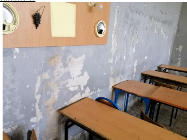
Figure 73 et 74: Ecaillage de la peinture.
