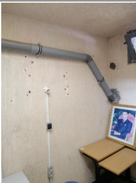
Figure 160,161 et 162 : Système d'assainissement non encastré.
