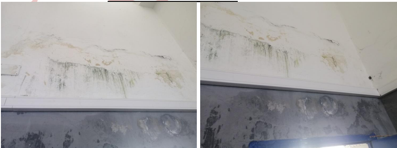
Figure 57 et 58 : Apparition des traces d'humidité.
