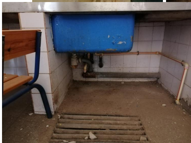
Figure 143,144,145,146,147 et 148 : Système d'assainissement non encastré et apparition de corrosion.
