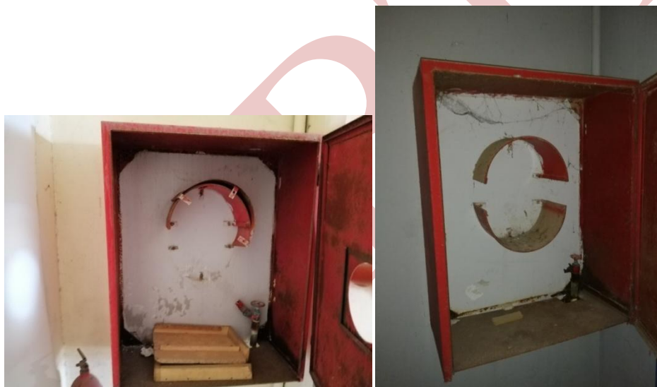
Figure 141 et 142 : Absence de système protection d'incendie.
