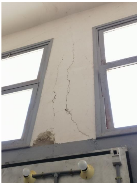
Figure 75,76,77 et 78 : Apparition des fissures au niveau des enduits.
