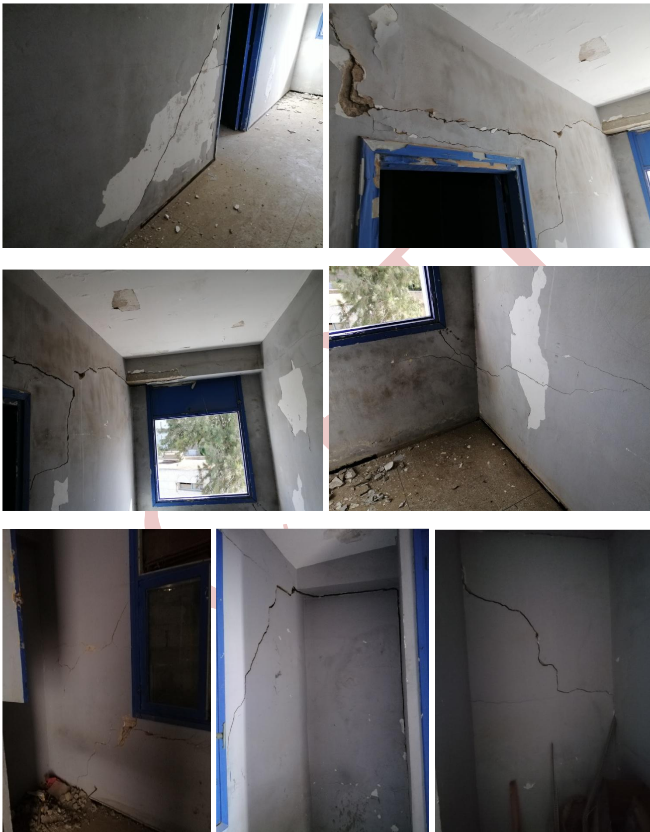
Figure 7,8,9,10,11,12 et 13: Apparition des fissures horizontales et à 45° profond dépasse 2mm de large.
