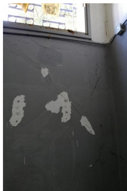
Figure 83,84 et 85 : Apparition des fissures au niveau des enduits.
