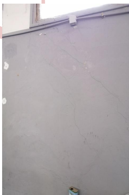
Figure 83,84 et 85 : Apparition des fissures au niveau des enduits.
