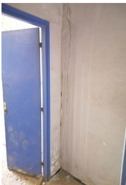
Figure 24,25,25,27 et 28 : Dégradation des enduits, Apparition des traces d'humidité et écaillage de la peinture.
