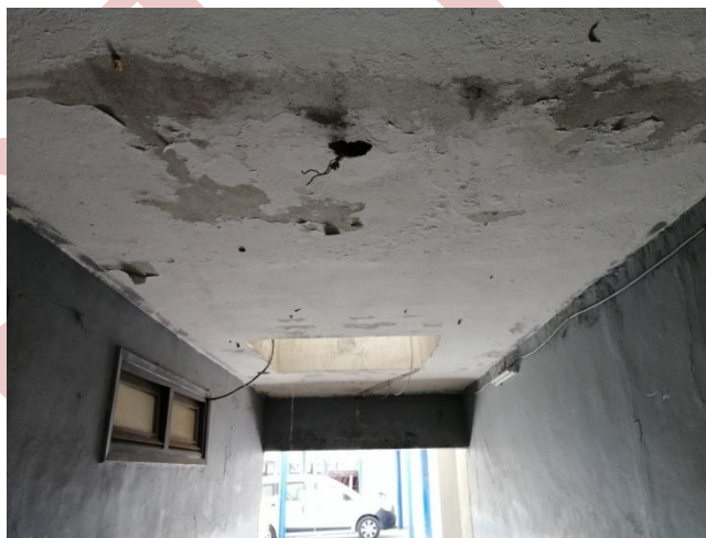
Figure 90,91,92,93 et 94 : Apparition des traces d'humidité et écaillage de la peinture.
