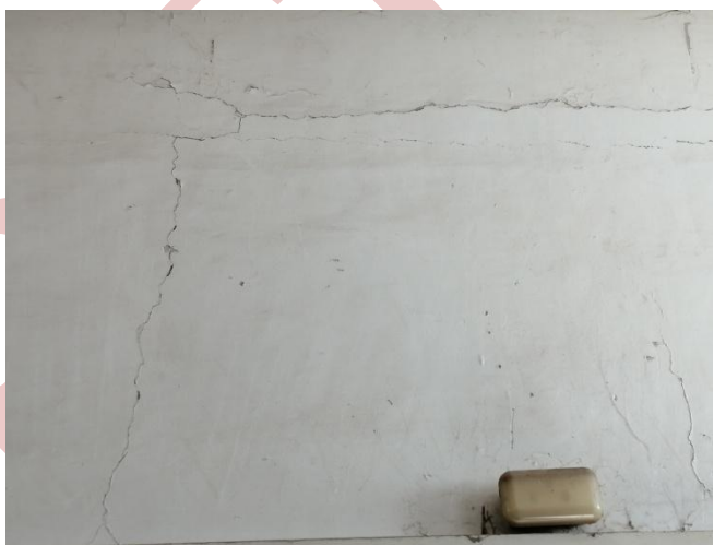
Figure 67,68,69,70,71 et 72 : Apparition des fissures au niveau des enduits.
