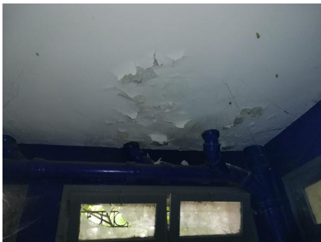
Figure 90,91,92,93 et 94 : Apparition des traces d'humidité et écaillage de la peinture.
