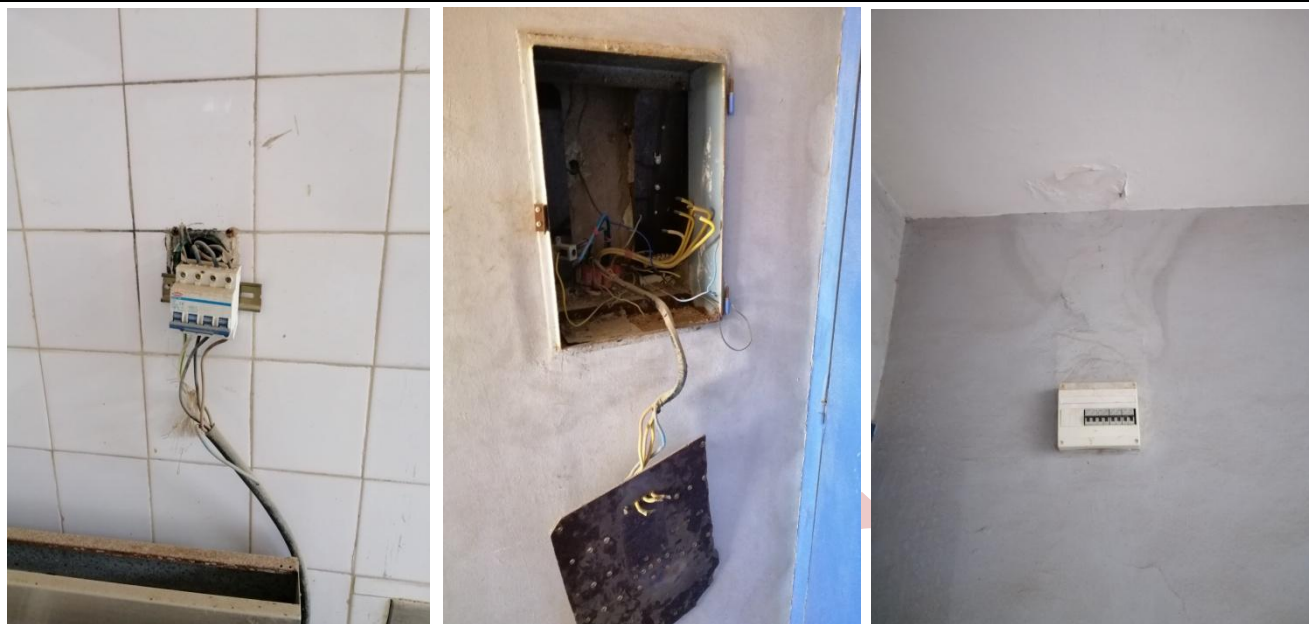
Figure 135,136,137,138,139 et 140 : Disjoncteurs et interrupteur différentiels non couvert.
