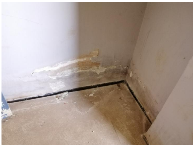
Figure 24,25,25,27 et 28 : Dégradation des enduits, Apparition des traces d'humidité et écaillage de la peinture.
