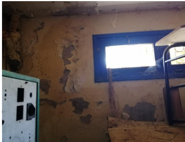
Figure 1,2,3,4,5 et 6 : Dégradation des enduits, Apparition des traces d'humidité et écaillage de la peinture.
