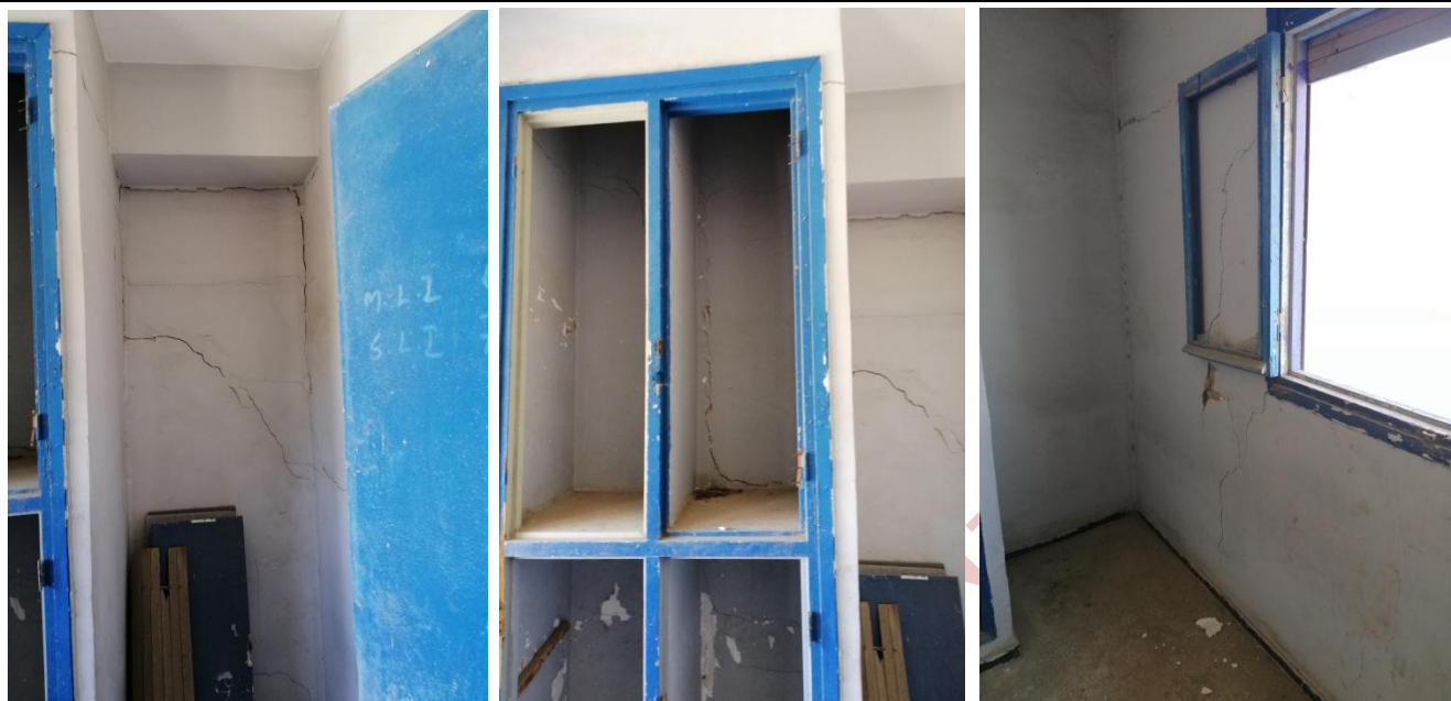
Figure 29,30,31,32,33,34,35,36,37,38,39,40,41,42 et 43: Apparition des fissures horizontales et à 45° profond dépasse 2mm de large.
