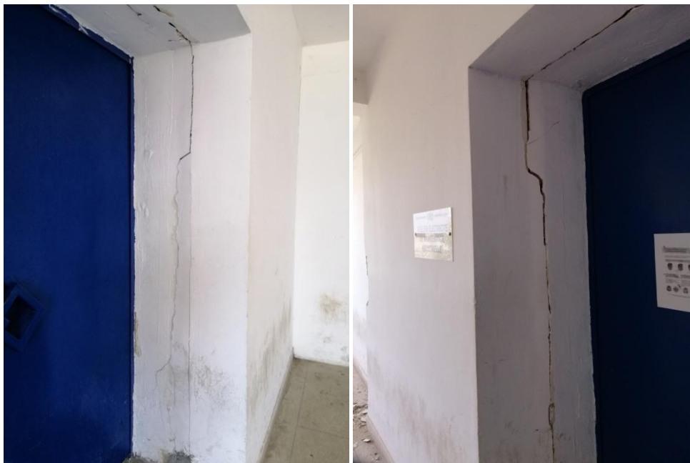
Figure 86 et 87 : Apparition des fissurations au niveau des enduits.
