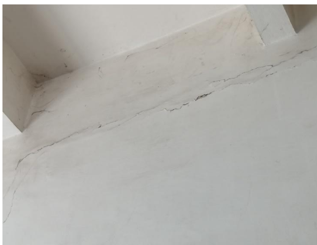
Figure 67,68,69,70,71 et 72 : Apparition des fissures au niveau des enduits.
