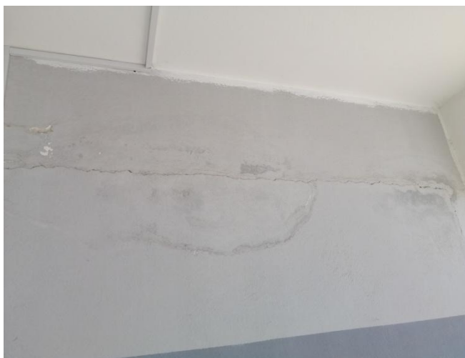
Figure 95,96,97 et 98 : Ecaillage de la peinture.
