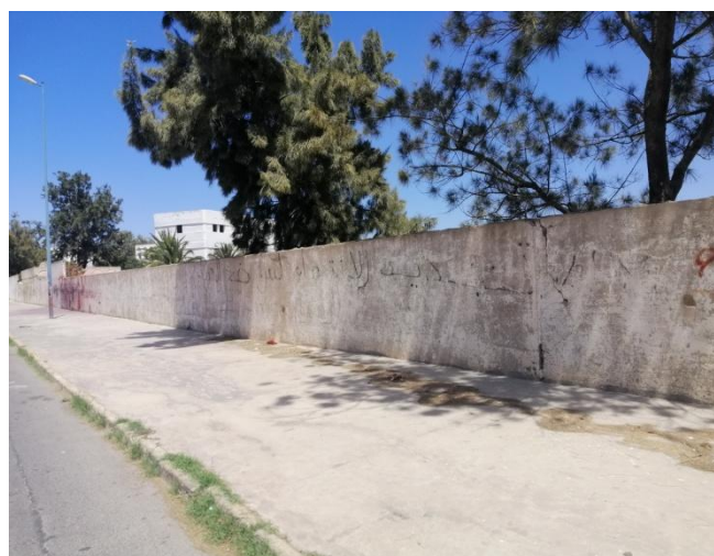
Figure 103, 104,105,106,107 et 108 : Apparition des traces d'humidité et écaillage de la peinture.
