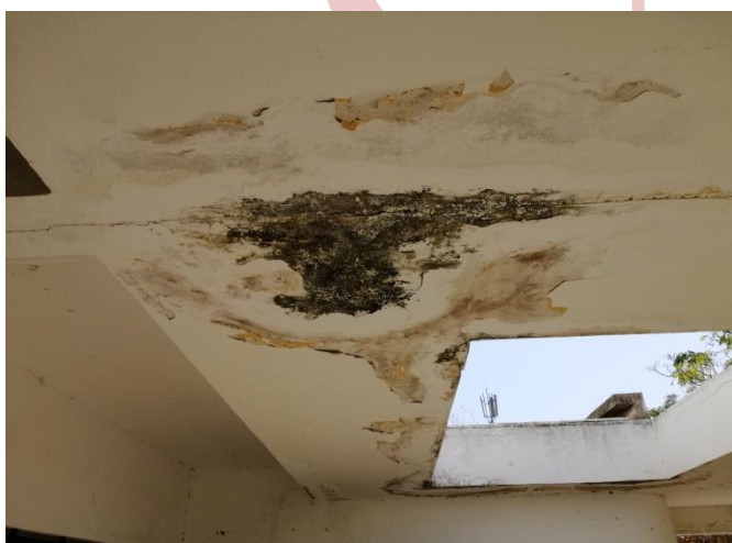
Figure 1,2,3,4,5 et 6 : Dégradation des enduits, Apparition des traces d'humidité et écaillage de la peinture.
