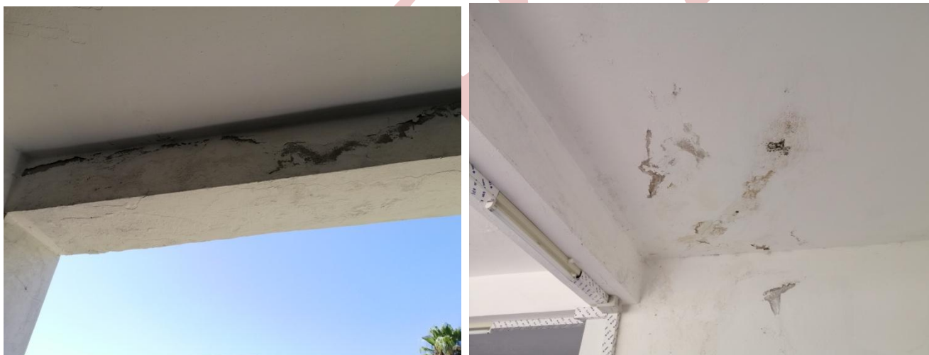
Figure 88 et 89 : Apparition des traces d'humidité et écaillage de la peinture.
