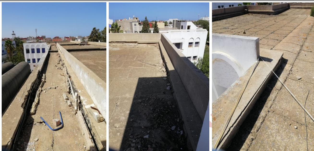
Figure 114,115 et 116 : Dégradation de système d'étanchéité, et des acrotères au niveau de bloc des classes.
