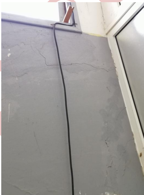
Figure 75,76,77 et 78 : Apparition des fissures au niveau des enduits.
