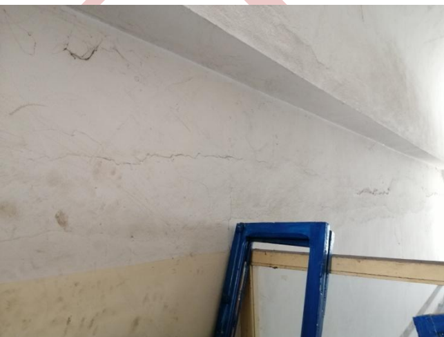
Figure 63,64,65 et 66 : Apparition des traces d'humidité et écaillage de la peinture.
