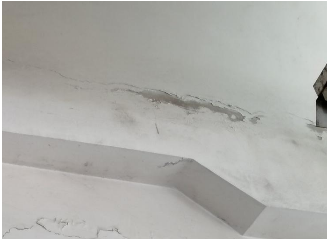
Figure 63,64,65 et 66 : Apparition des traces d'humidité et écaillage de la peinture.
