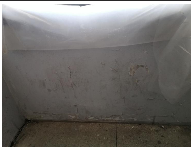
Figure 95,96,97 et 98 : Ecaillage de la peinture.
