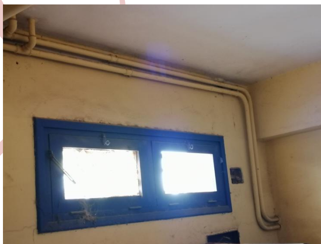
Figure 149 : Tuyauterie non encastré.
