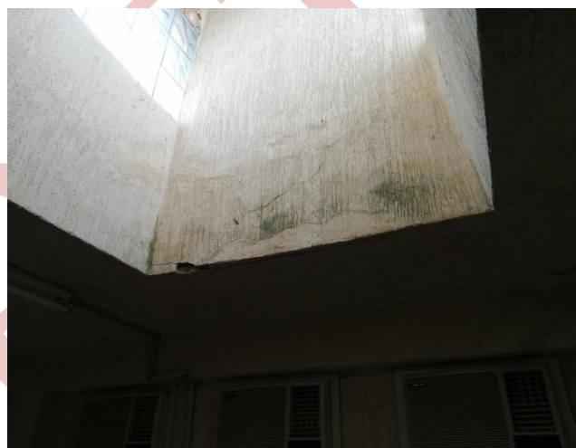
Figure 81 et 82: Apparition des traces d'humidité.
