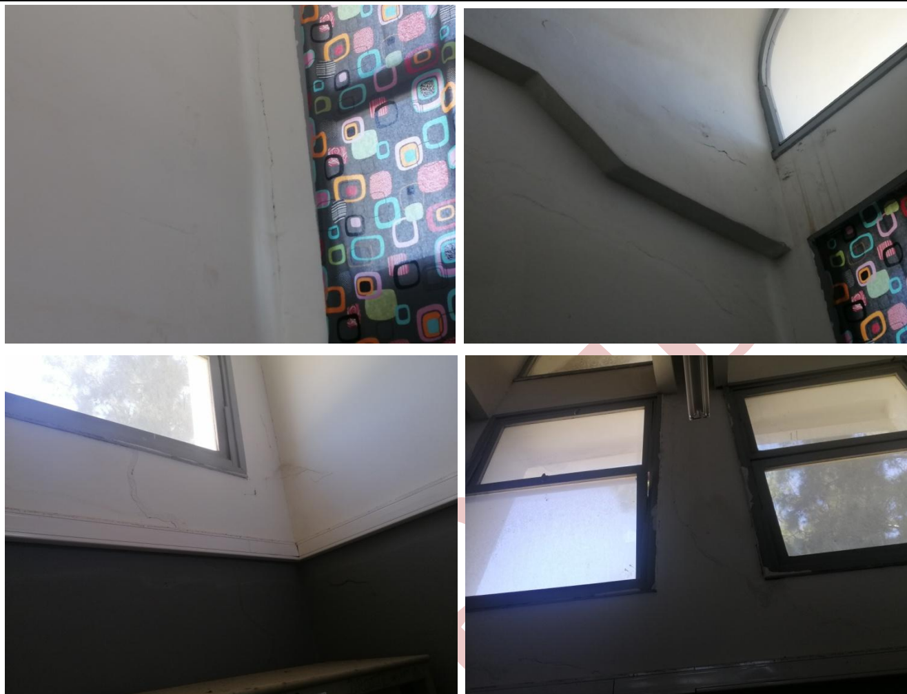
Figure 59,60,61 et 62 : Apparition des fissures au niveau des enduits.
