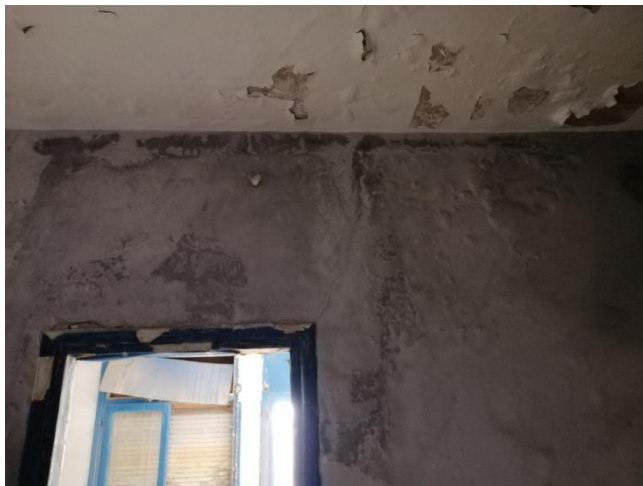
Figure 24,25,25,27 et 28 : Dégradation des enduits, Apparition des traces d'humidité et écaillage de la peinture.
