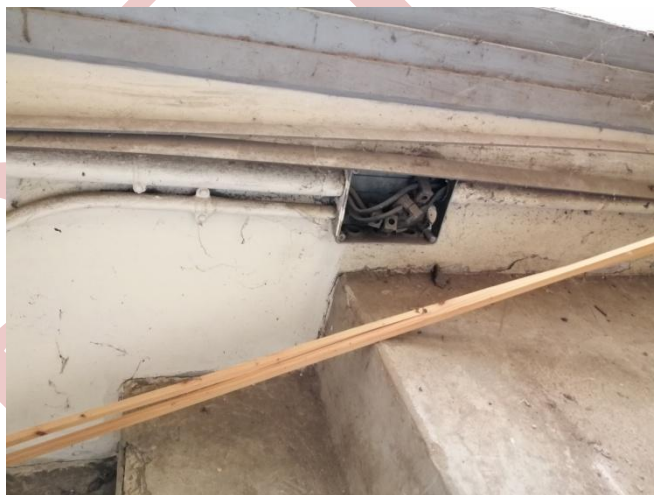
Figure 155,156,157,158 et 159 : Disjoncteurs et interrupteur différentiels non couverts.
