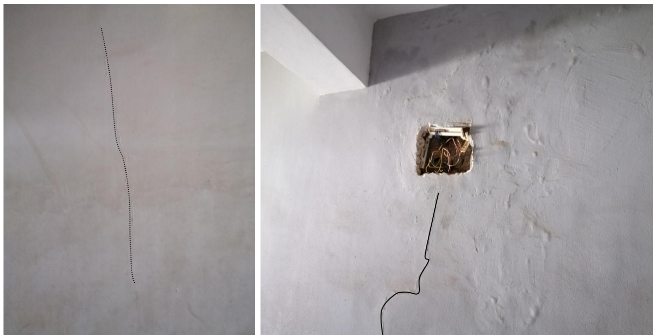
Figure 22 et 23: Fissuration au niveau des enduits.
