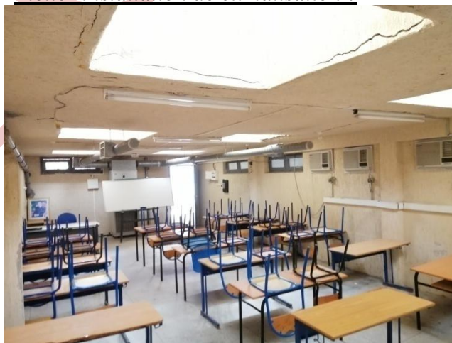
Figure 79: Apparition des fissures au niveau des enduits.
