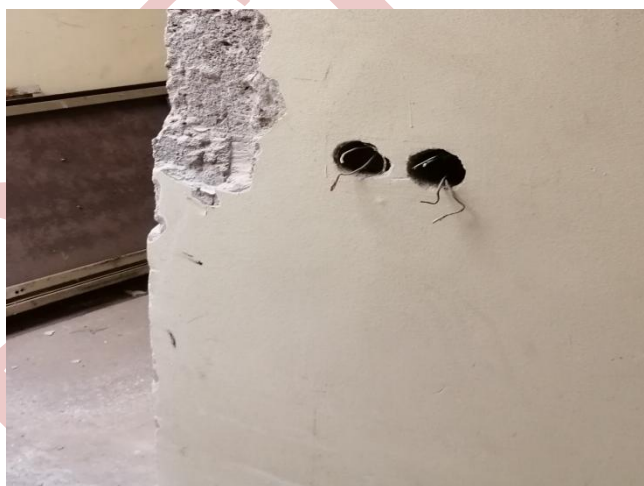
Figure 133 et 134 : Prises de courant non isolés.
