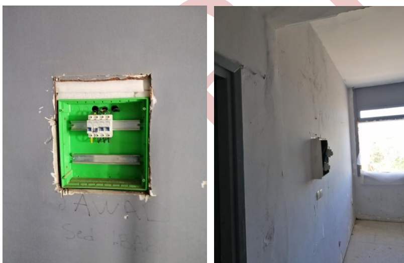
Figure 163 et 164 : Disjoncteurs et interrupteur différentiels non couverts.
