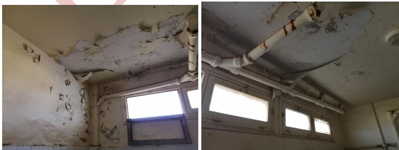
Figure 17,18 et 19: Apparition des traces d'humidité.
