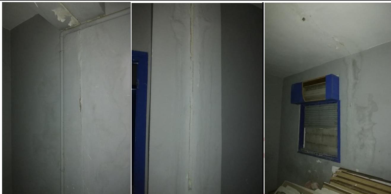
Figure 14,15 et 16: Apparition des fissures au niveau des joints entre bloc.
