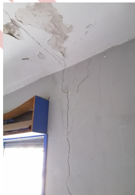
Figure 24,25,25,27 et 28 : Dégradation des enduits, Apparition des traces d'humidité et écaillage de la peinture.
