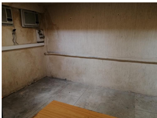
Figure 81 et 82: Apparition des traces d'humidité.
