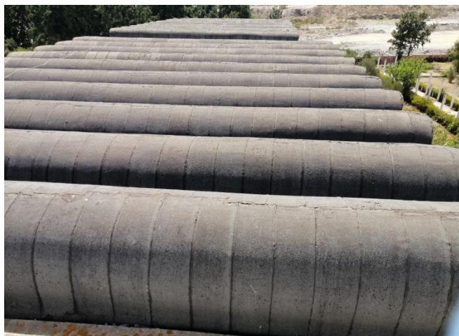
Figure 112 et 113 : Dégradation de système d'étanchéité, et des acrotères au niveau des ateliers.
