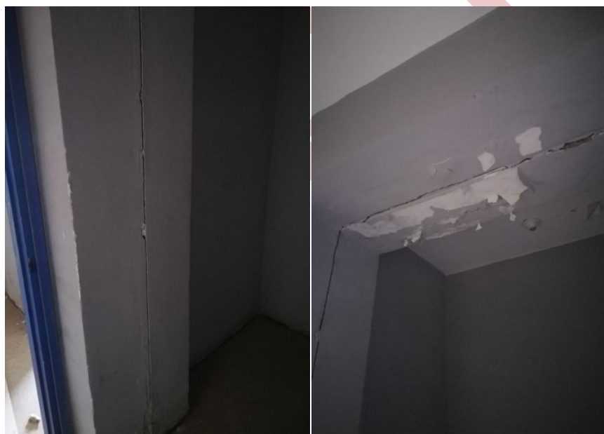
Figure 29,30,31,32,33,34,35,36,37,38,39,40,41,42 et 43: Apparition des fissures horizontales et à 45° profond dépasse 2mm de large.
