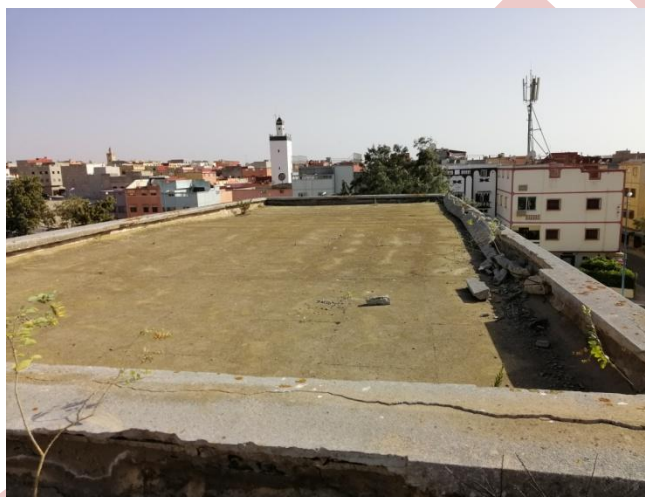
Figure 109, 110 et 111 : Dégradation de système d'étanchéité, et des acrotères au niveau d'internat.
