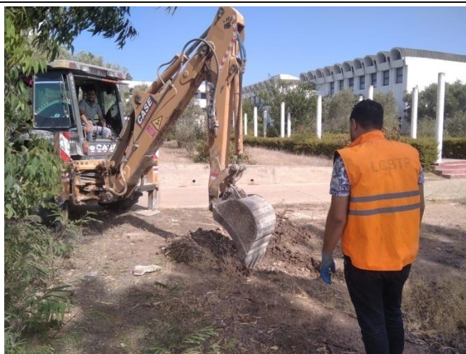
Figure 178, 179 et 180 : Réalisation des sondages.
