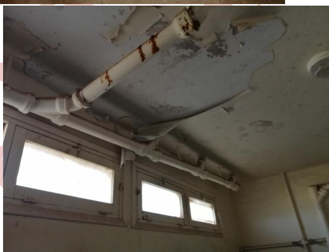
Figure 143,144,145,146,147 et 148 : Système d'assainissement non encastré et apparition de corrosion.
