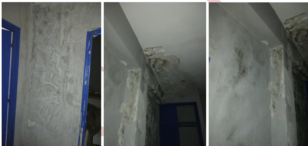
Figure 17,18 et 19: Apparition des traces d'humidité.
