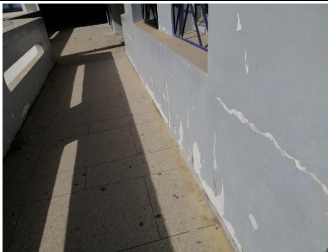
Figure 95,96,97 et 98 : Ecaillage de la peinture.
