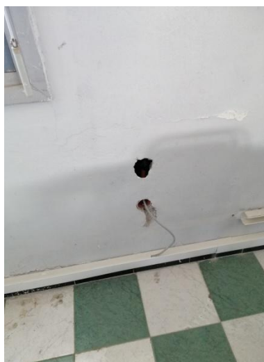
Figure 165 : Prises de courant non isolés.
