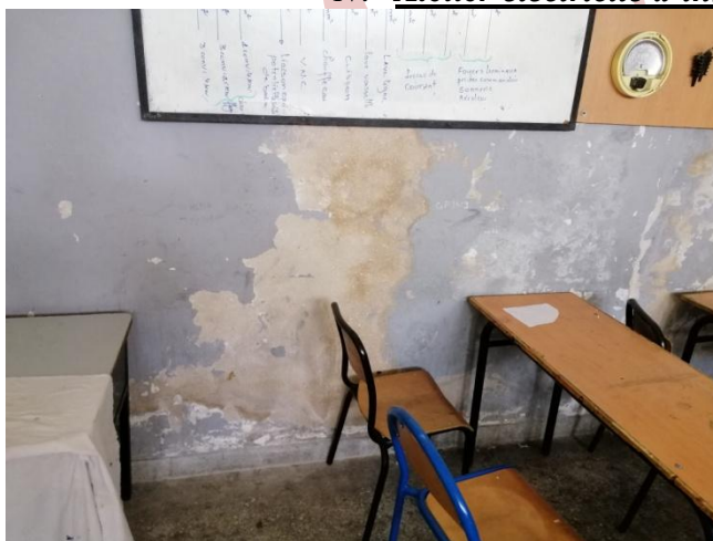
Figure 73 et 74: Ecaillage de la peinture.
