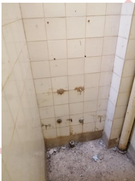
Figure 150,151 et 152 : Robinetterie non fonctionnel.
