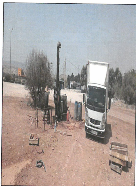
Photo N°19: Exécution des sondages carottés
