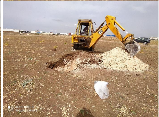
Vues générales et moyens mis en œuvre pour l'exécution des sondages mécaniques
