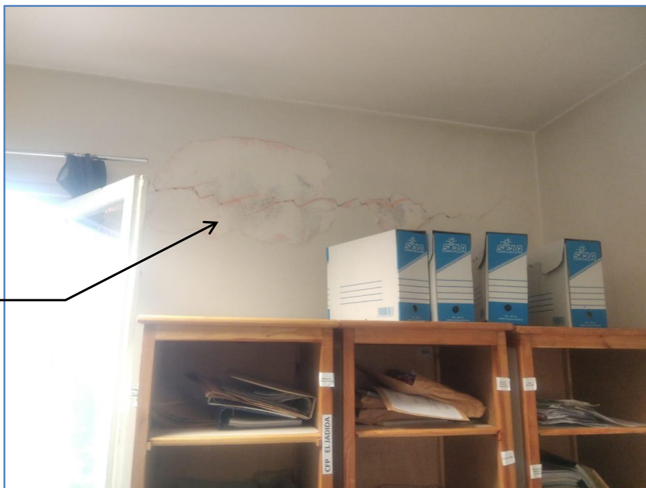
Figure 5: Photos illustrant des traces d'humidités, décollement de revêtement et fissurations
