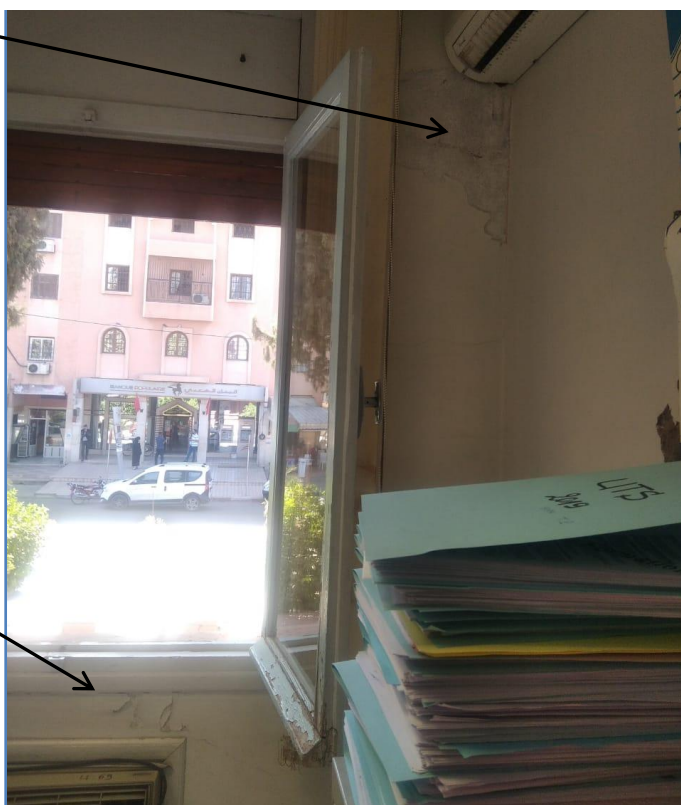
Figure 6: photos illustrant l'écaillage de peinture et traces d'humidité dues aux infiltrations des eaux pluviales au niveau du climatiseur
