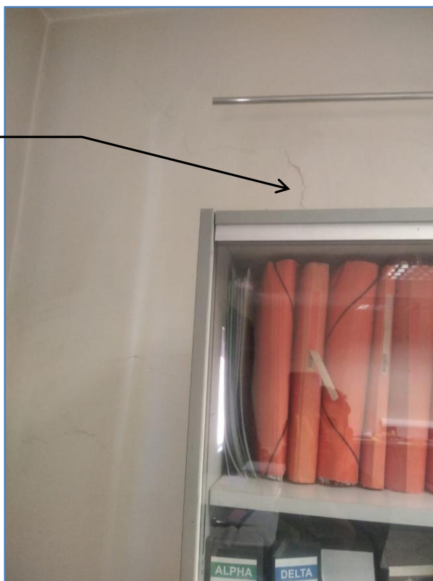
Figure 3 : Photos illustrant les fissurations au niveau des murs
