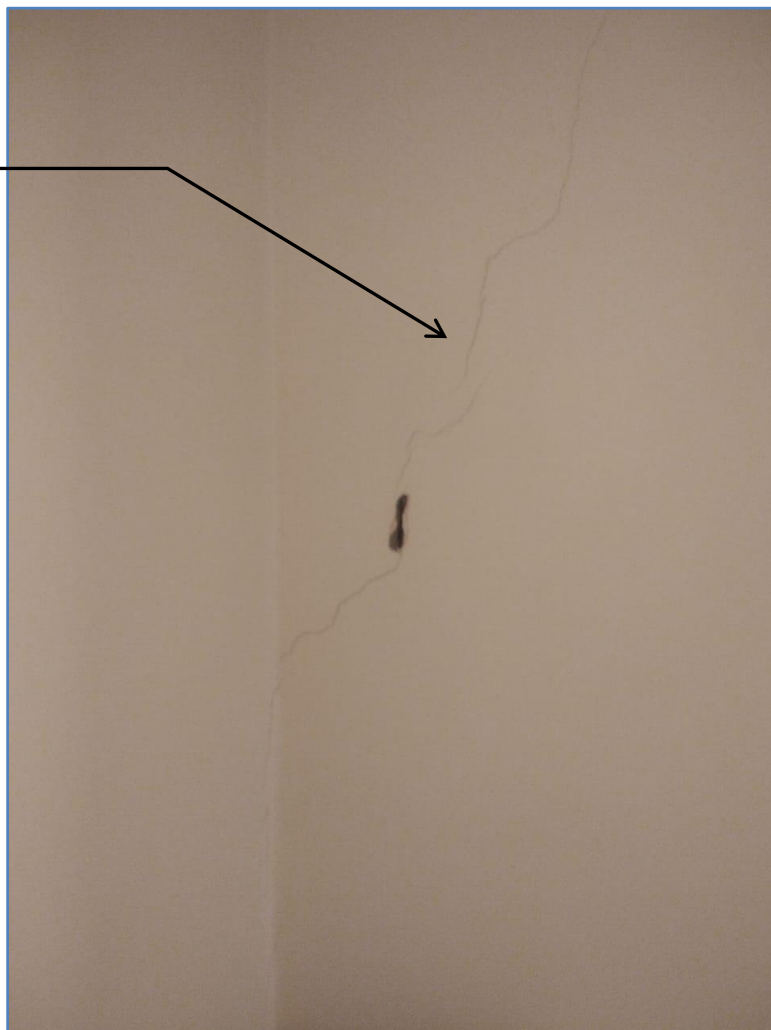
Figure 2 / Photos illustrant la fissures allant de part en part du mur
