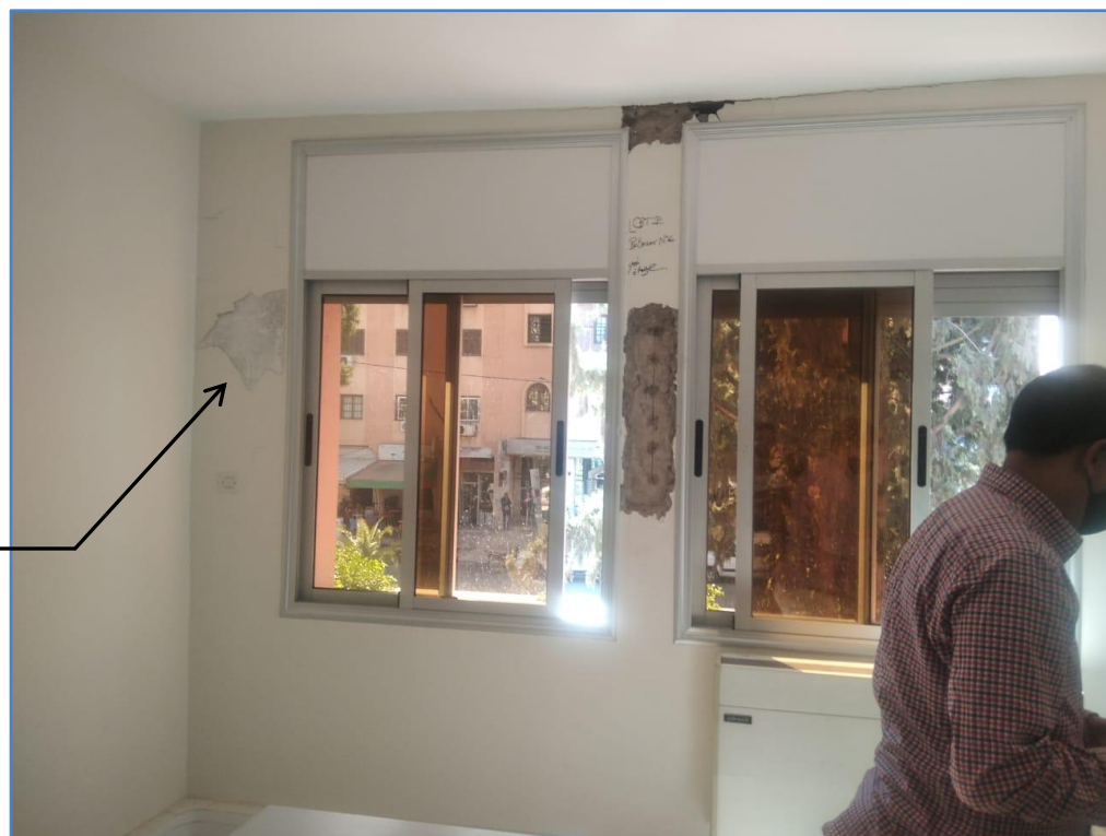
Figure 4: Photos illustrant des traces d'humidités et décollement de revêtement
