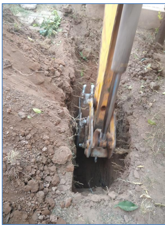
Fig 8 : Photos illustrant la réalisation des sondages
