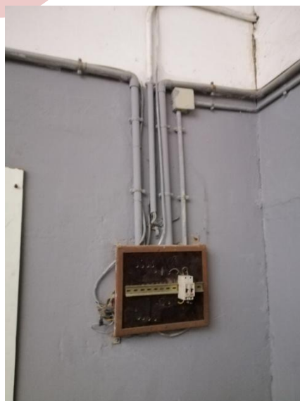
Figure 71 : Interrupteur différentiel non couvert.
