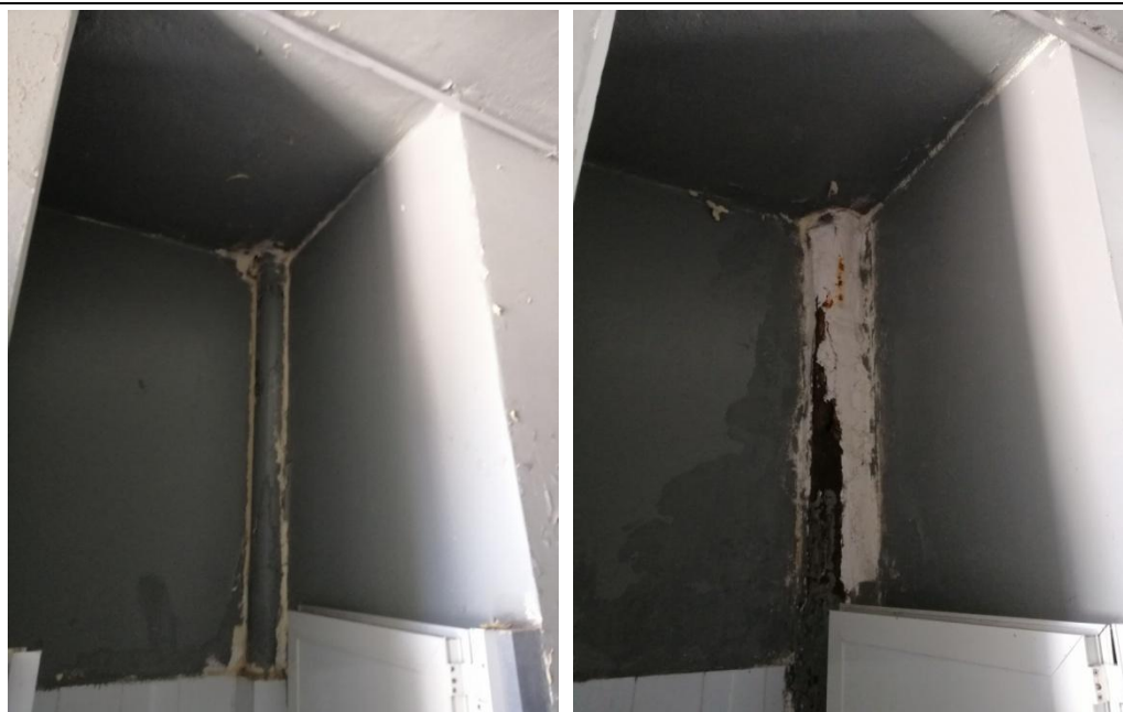
Figure 89 et 90 : Conduites des eaux pluviales non encastrés, avec apparition de corrosion.
