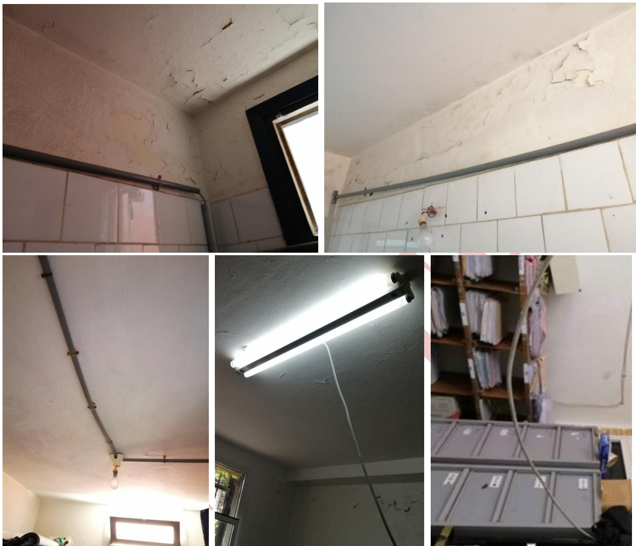
Figure 53, 54,55 et 56 : Câbles d'électricité non encastré.
