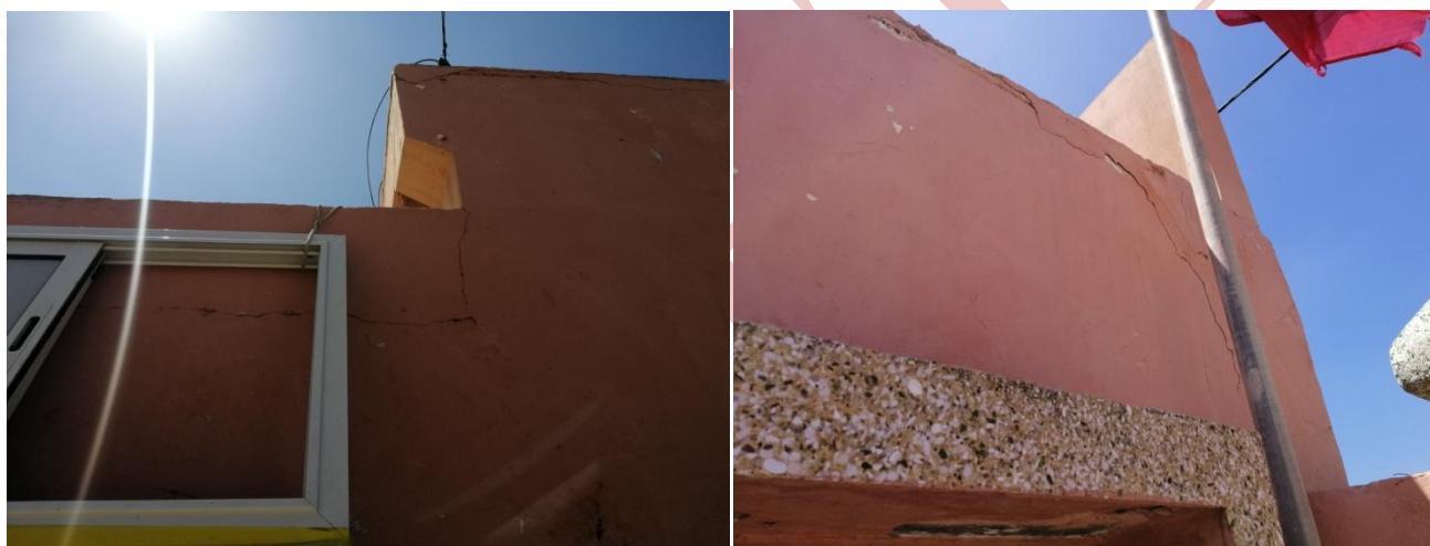
Figure 2 et 3: Fissuration au niveau des murs extérieur.
