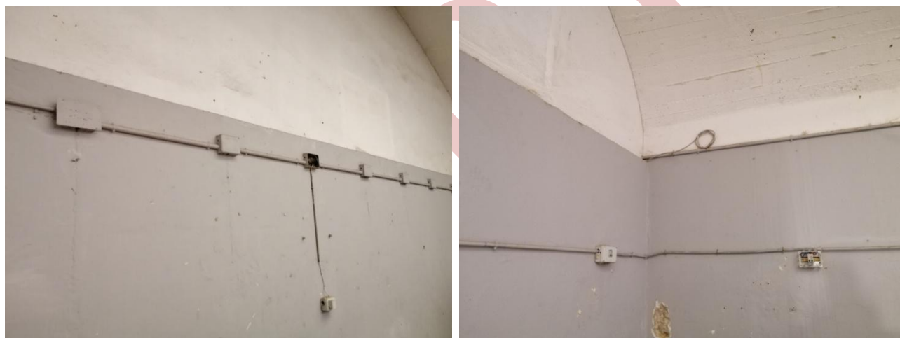
Figure 69 et 70 : Boite de dérivation non couvert.
