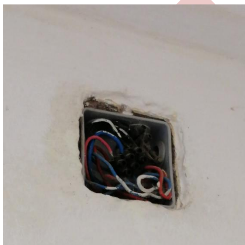
Figure 50 : Boîte de dérivation non couverte.
