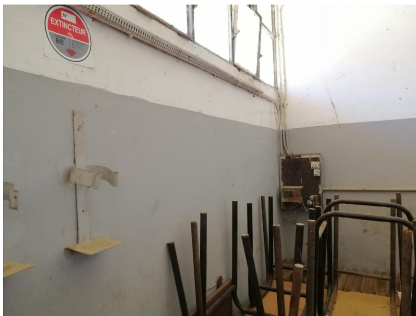
Figure 58 : Tableau non encastré, classique avec des câbles électrique non encastré passant dans un tube..
