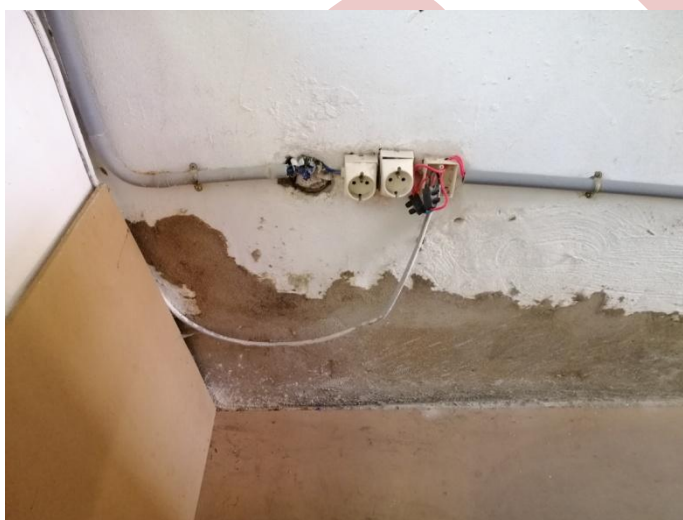
Figure 81 : Prises de courant non isolés.
