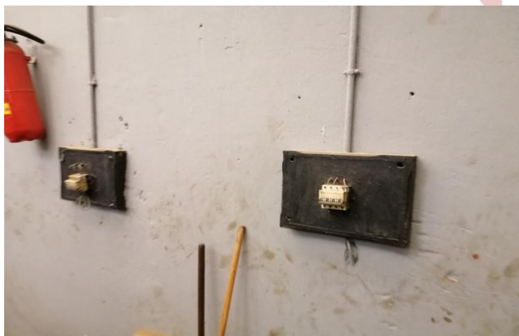
Figure 73 et 74 : Interrupteur différentiel non couvert.
