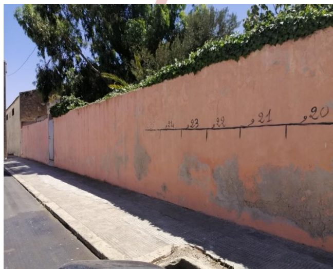
Figure 42,43,44,45,46 et 47 : Vue latérale de mur de clôture, Ecaillage de la peinture et fissuration superficiel au niveau des enduits.
