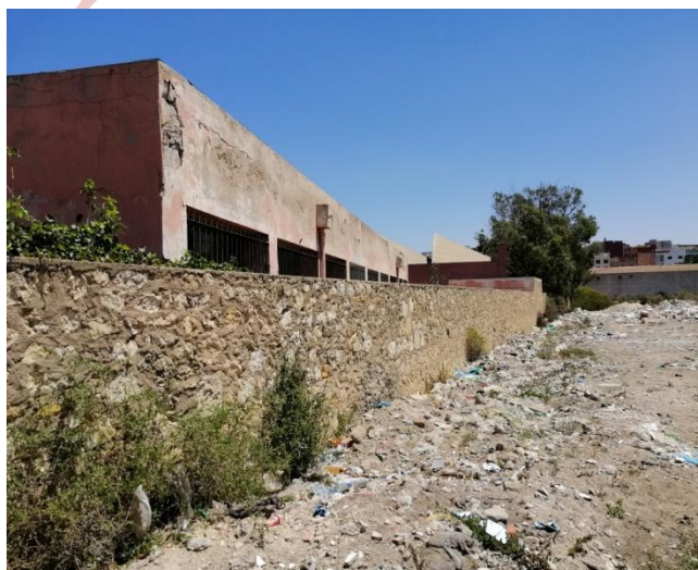
Figure 42,43,44,45,46 et 47 : Vue latérale de mur de clôture, Ecaillage de la peinture et fissuration superficiel au niveau des enduits.
