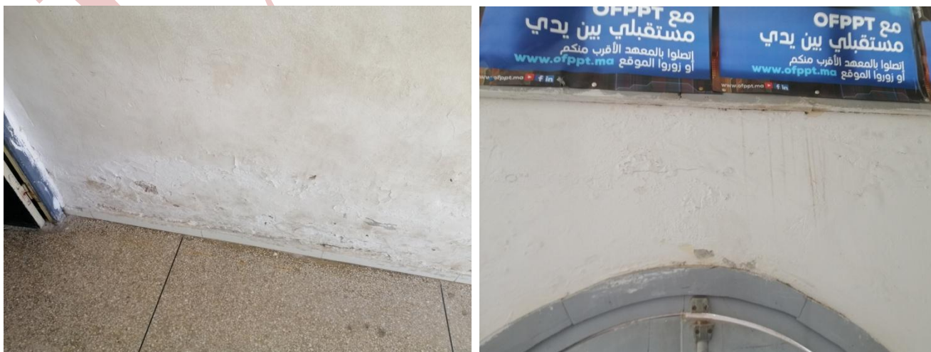
Figure 36 et 37 : Apparition des traces d'humidité et écaillage de la peinture.
