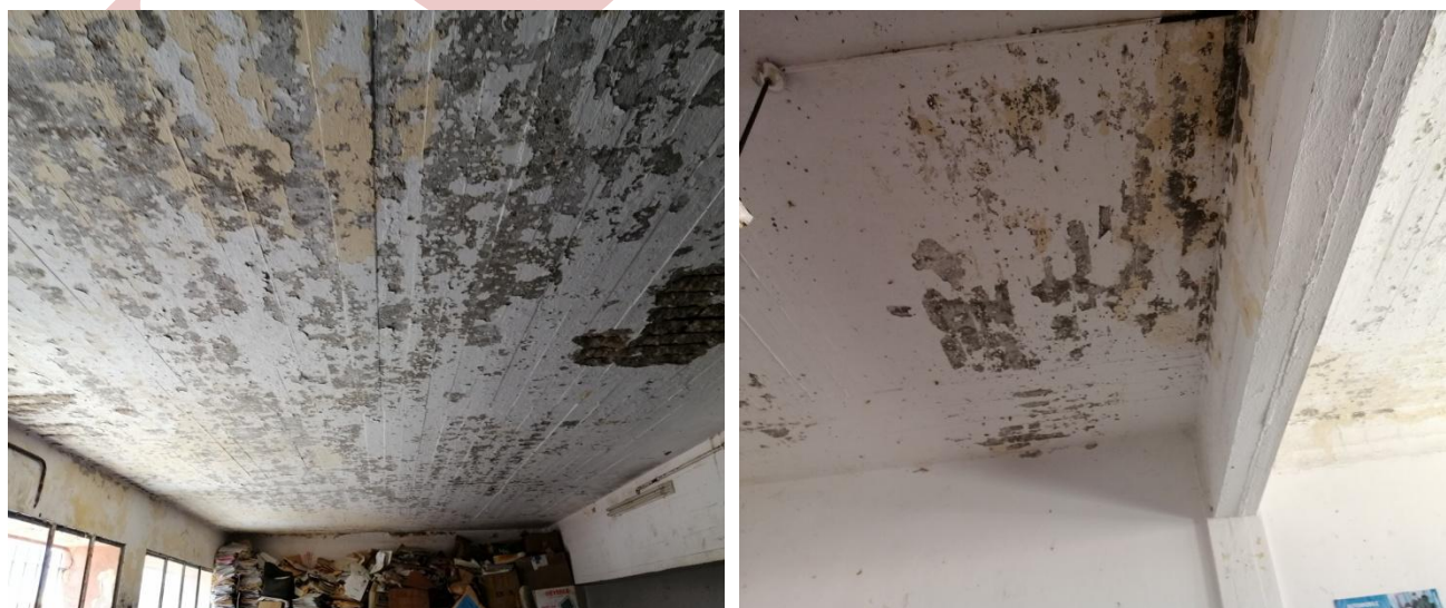
Figure 14 et 15: Apparition des traces d'humidité, écaillage de la peinture.
