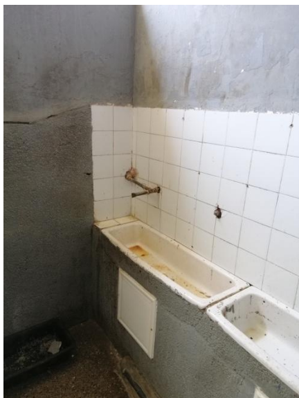
Figure 85,86 et 87 : Dégradation de la robinetterie et corrosion an niveau de raccords.
