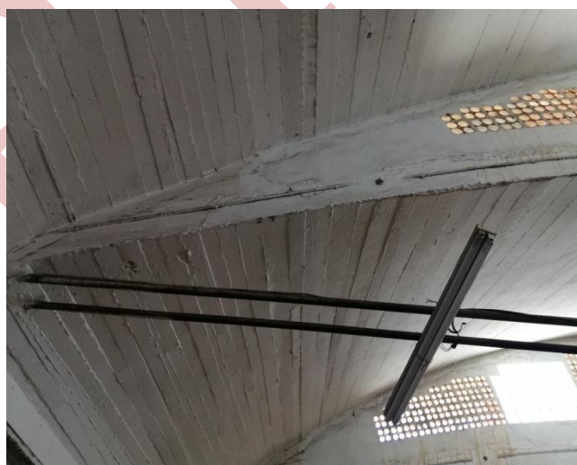
Figure 29 et 30 : Apparition des fissurations et écaillage de la peinture.
