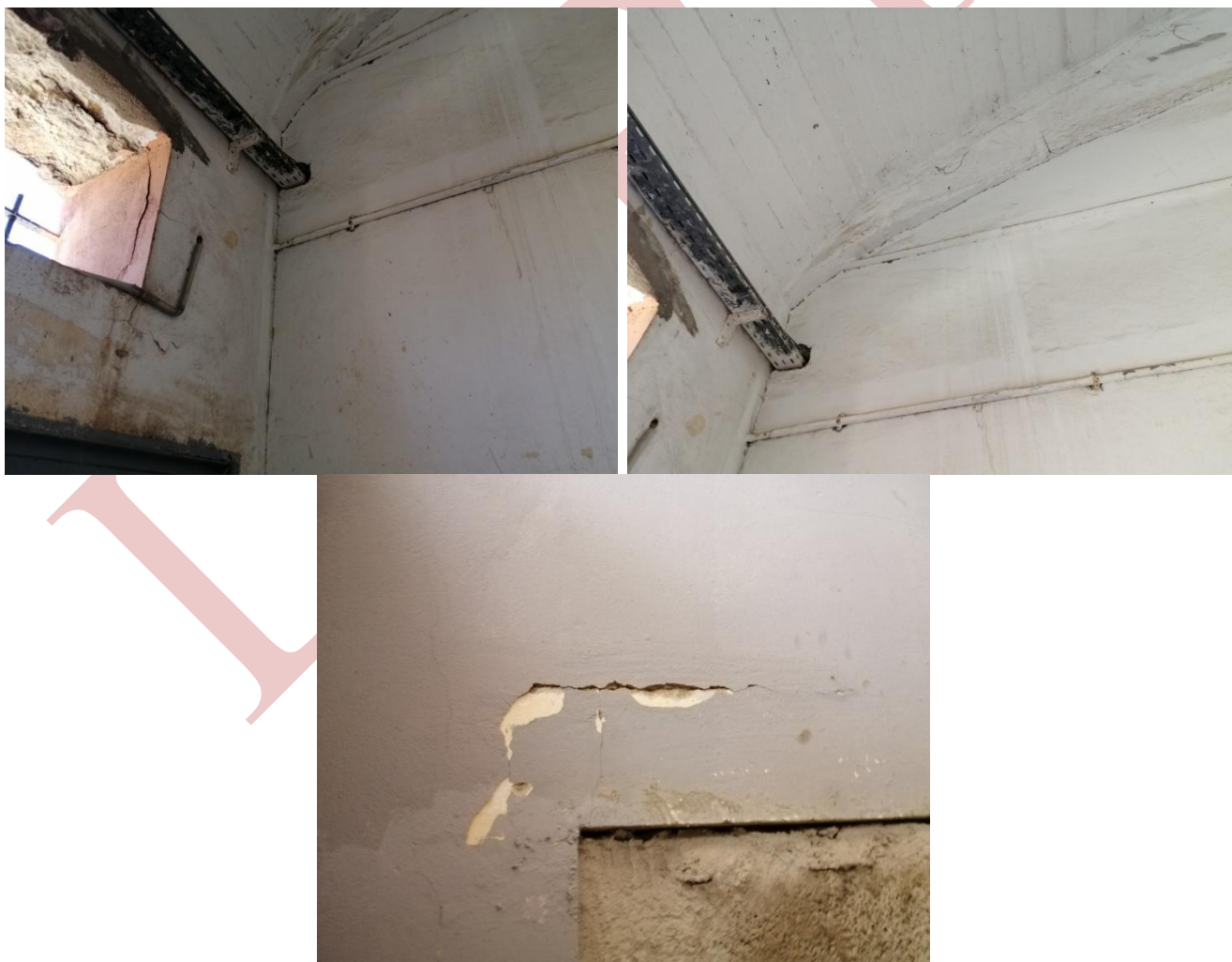
Figure 21,22 et 23 : Apparition des fissurations.
