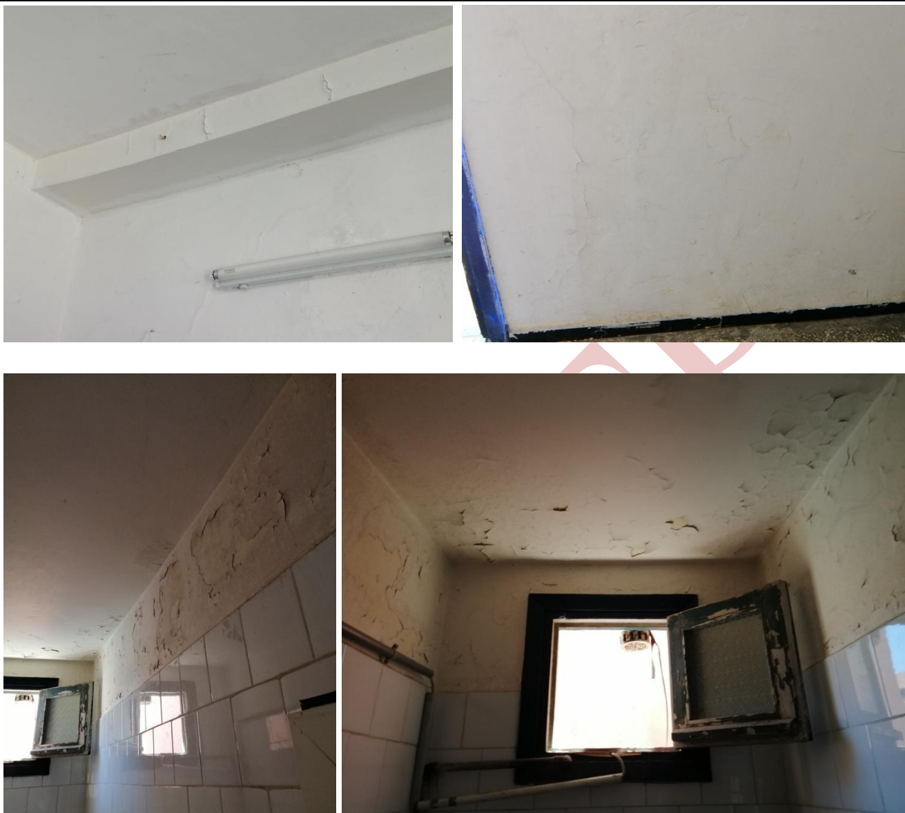
Figure 4,5,6,7,8 et 9: Apparition des traces d'humidité.
