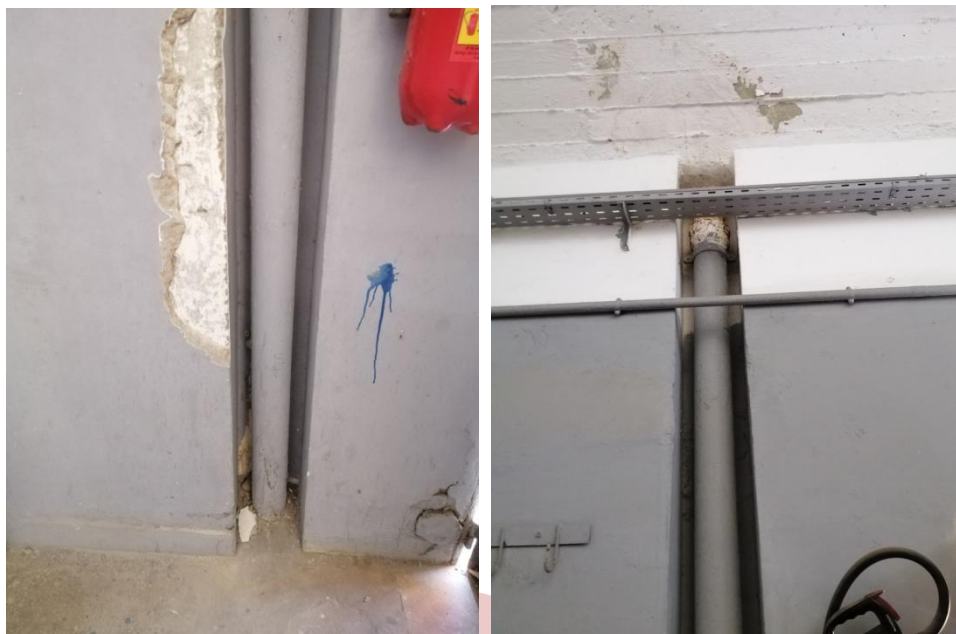
Figure 64 et 65 : Conduites des eaux pluviales non encastrés, avec apparition de corrosion au niveau de raccords.
