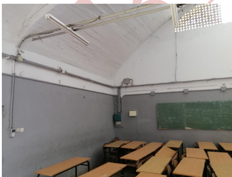
Figure 66 : Chemin de câble en tôle pour la distribution des câbles.
