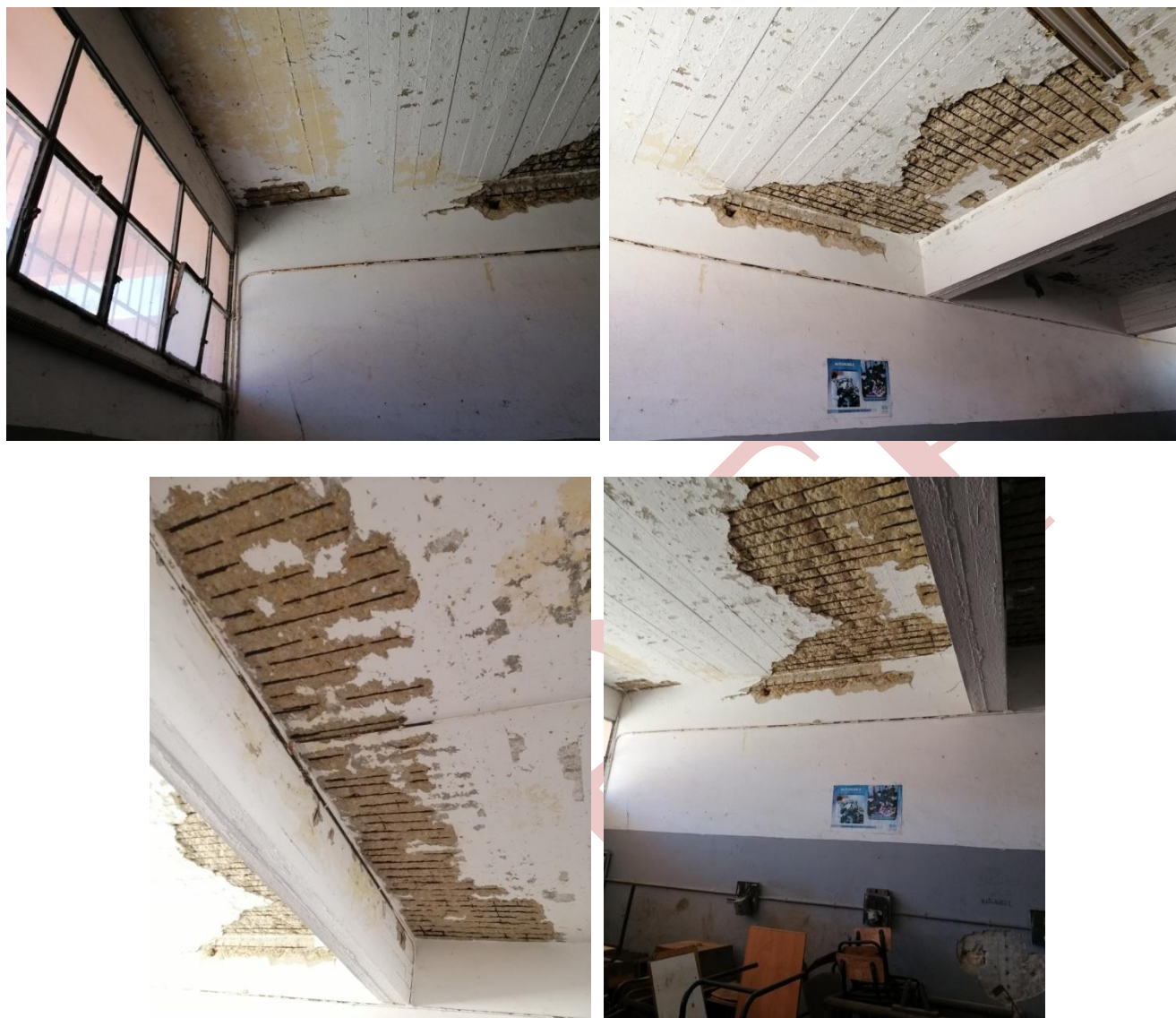
Figure 10,11,12 et 13: Apparition des aciers de la dalle attaquée par corrosion.
