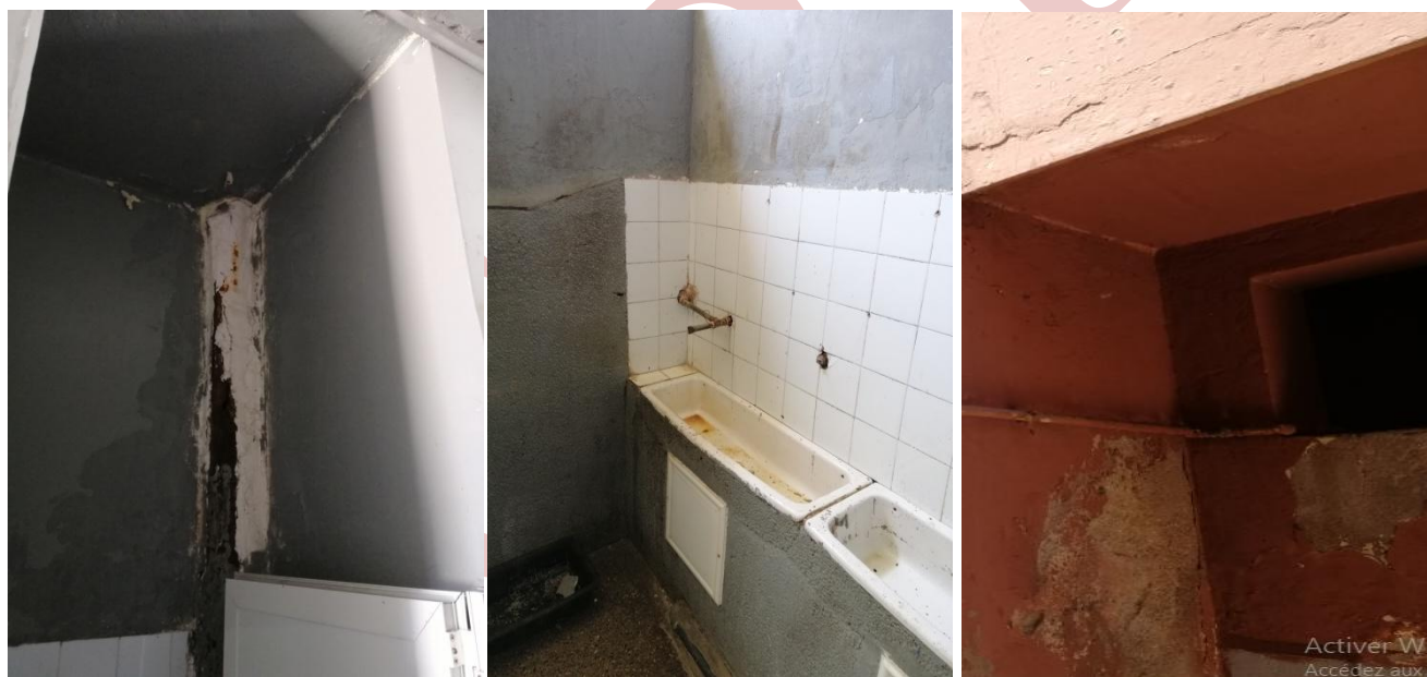
Figure 39,40 et 41 : Apparition des traces d'humidité.
