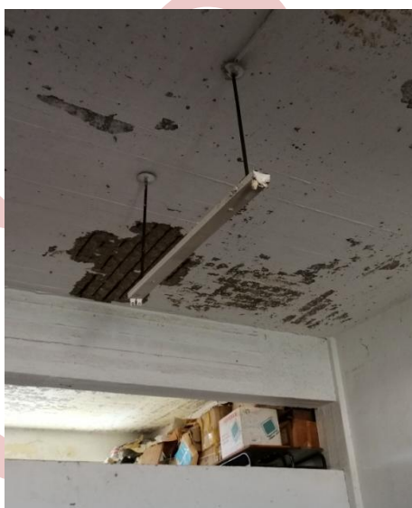
Figure 59,60 et 61 : Lampes Tube LED endommagé.
