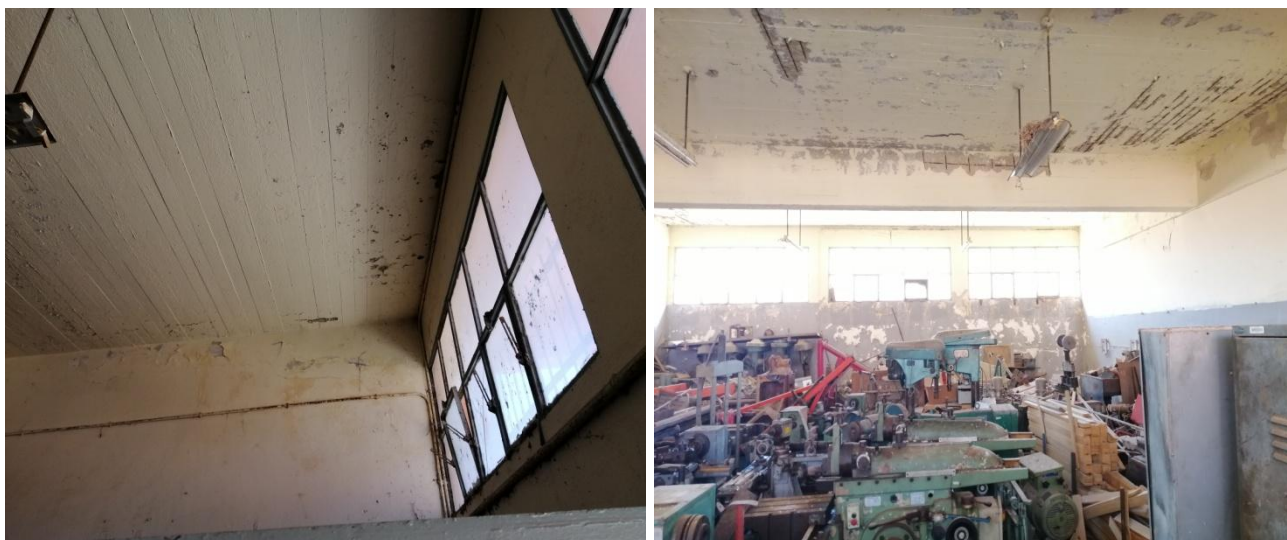
Figure 33 et 34 : Ecaillage de la peinture, apparition des aciers de la dalle.
