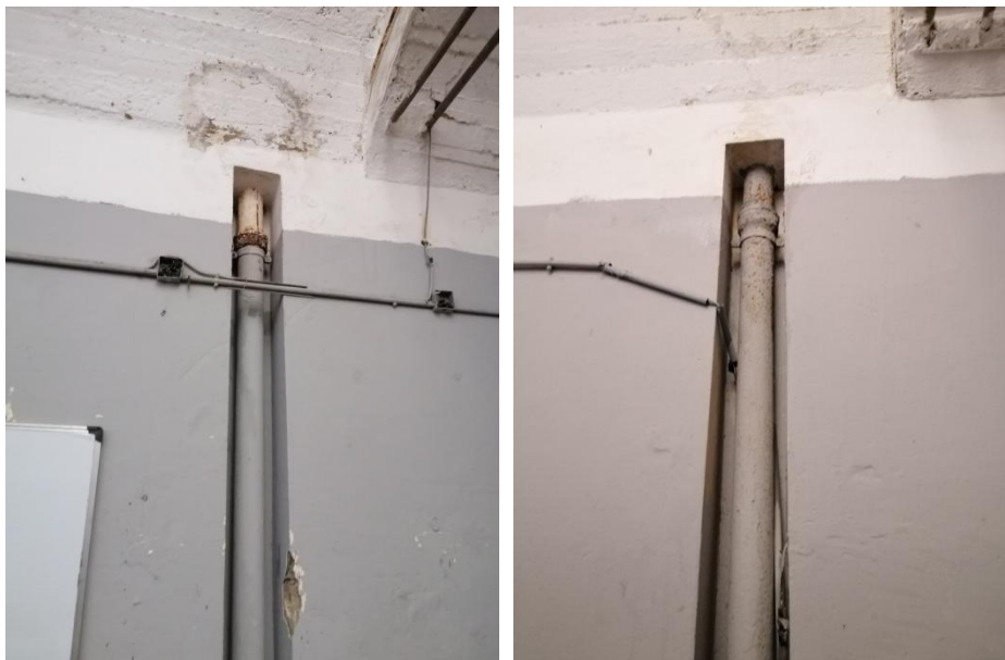
Figure 67 et 68 : Conduite des eaux pluviales non encastré avec apparition de corrosion au niveau de records.
