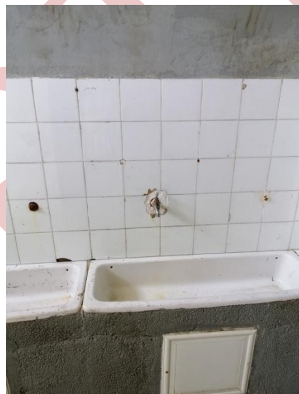
Figure 85,86 et 87 : Dégradation de la robinetterie et corrosion an niveau de raccords.
