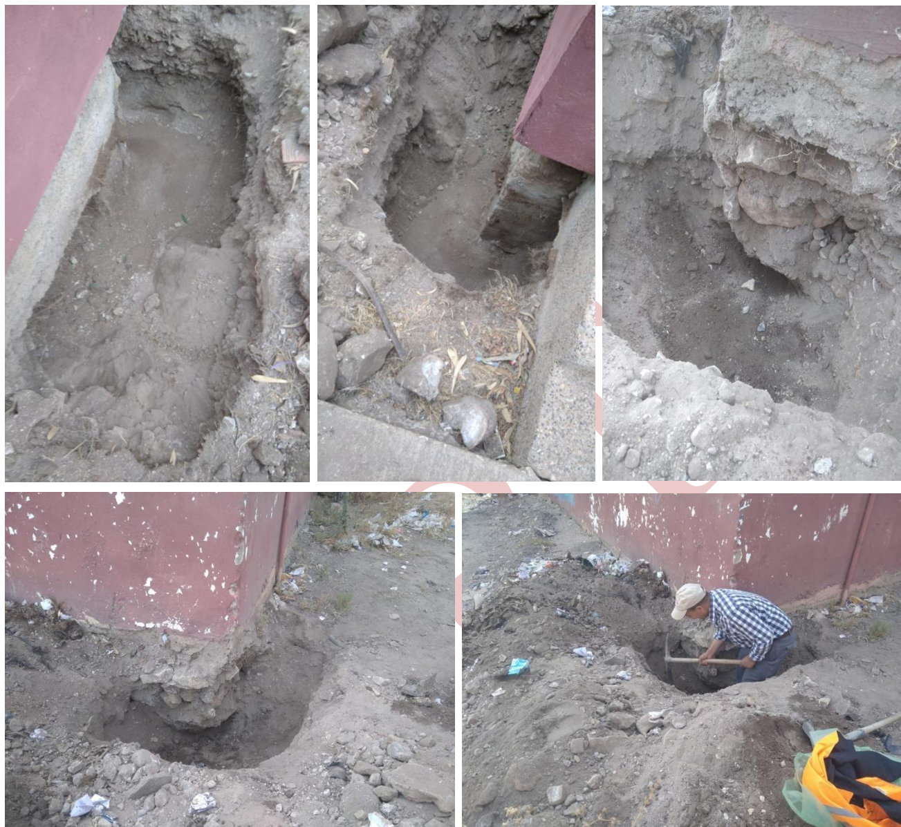
Figure 51, 52, 53, 54 et 55 : Sondages au niveau des fondations.
