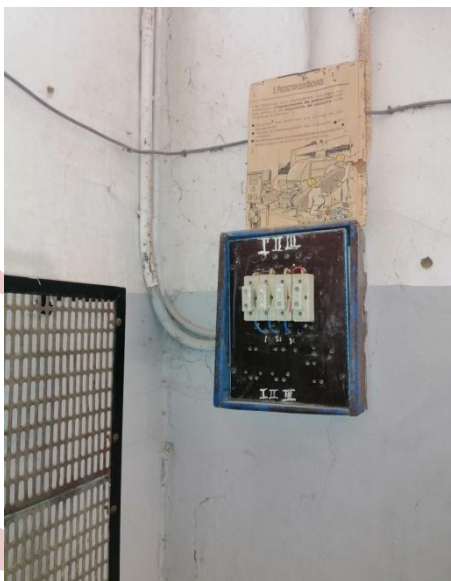
Figure 68 : Appareillage électrique non couvert.
