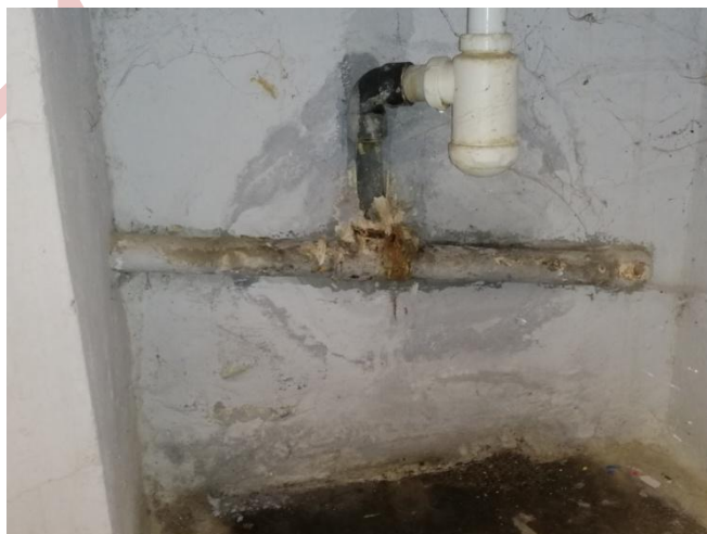
Figure 69: Fuite au niveau d'assemblage d'assainissement, apparition de corrosion.
