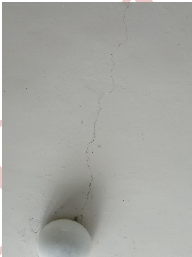
Figure 37 : Fissuration au niveau des enduits.
