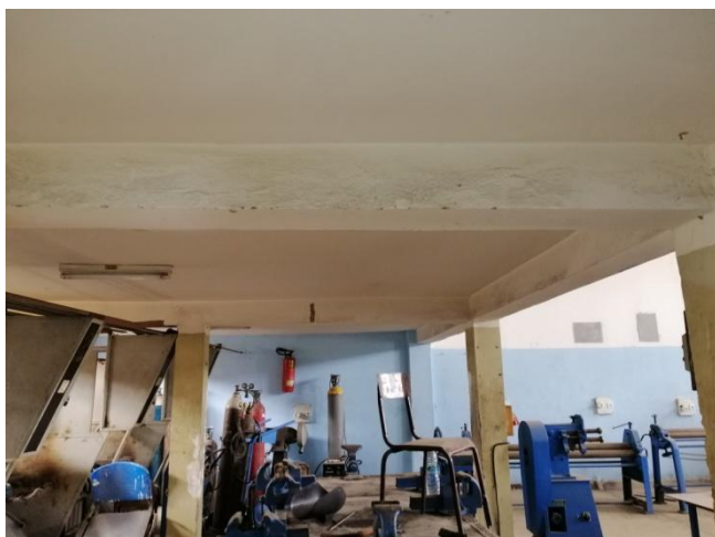
Figure 21 et 22 : Apparition des traces d'humidité et écaillage de la peinture.
