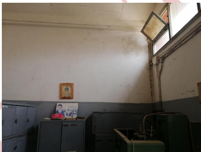
Figure 23: Apparition des traces d'humidité et écaillage de la peinture.
