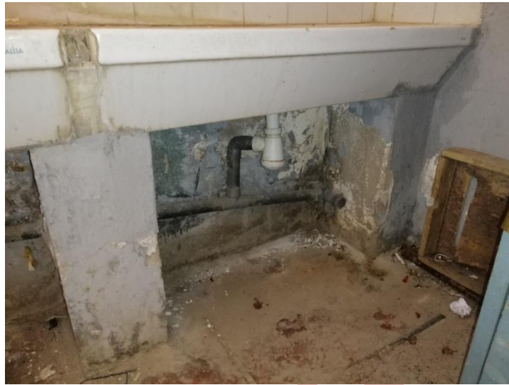
Figure 6 : Traces d'humidité.
