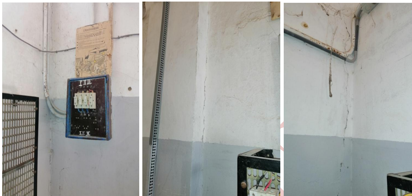
Figure 11, 12 et 13 : Apparition des fissures au niveau des enduits.
