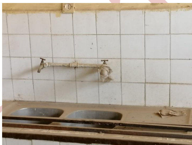
Figure 94 : Robinetterie non fonctionnel.
