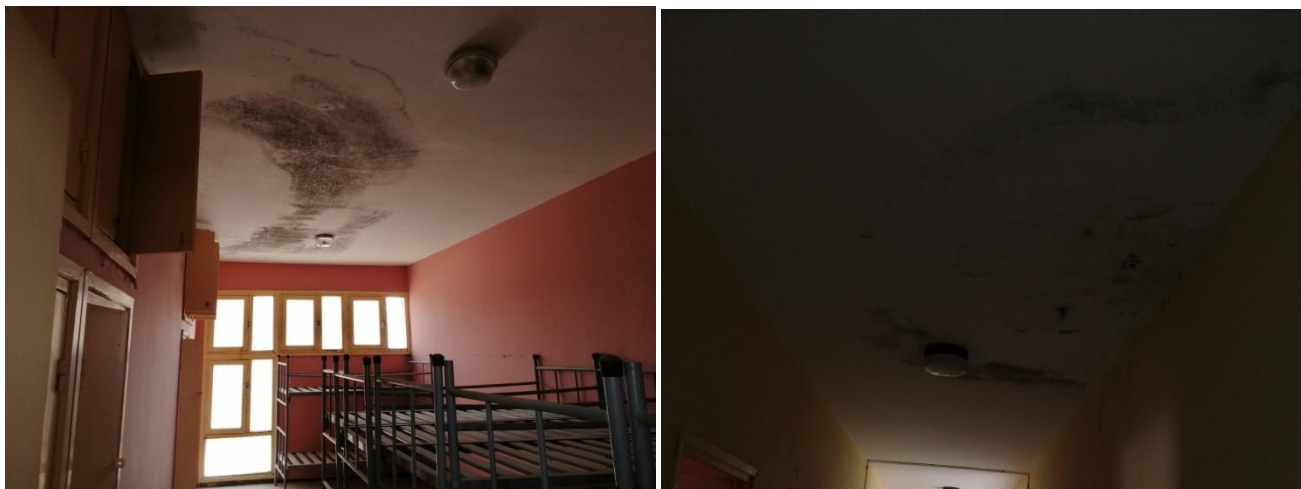
Figure 28 et 29 : Apparition des fissurations au niveau des enduits.
