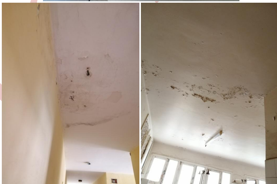
Figure 30, 31, 32, 33 et 34 : Apparition des traces d'humidité et écaillage de la peinture.
