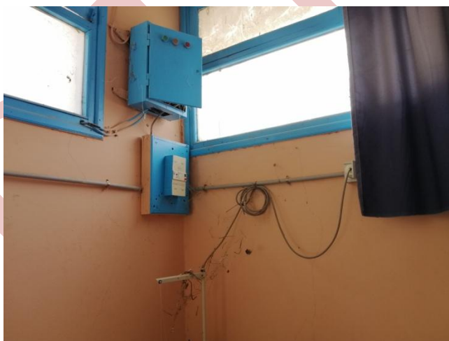
Figure 61 : Interrupteur différentiel et disjoncteur non couverts.
