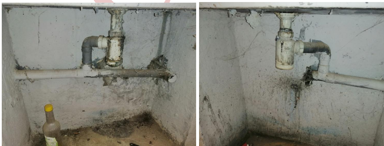
Figure 82 et 83: Fuite au niveau d'assemblage d'assainissement.
