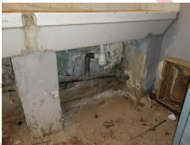
Figure 64 : Fuite au niveau d'assemblage d'assainissement.
