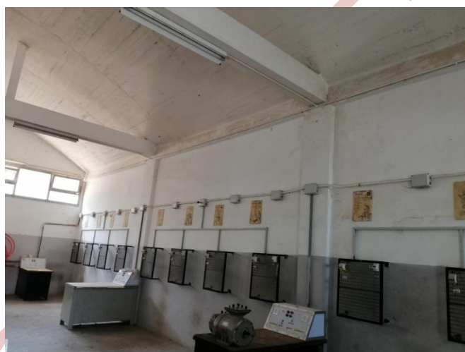
Figure 71 : Câbles électrique non encastré passant dans un tube avec des boites de dérivation.
