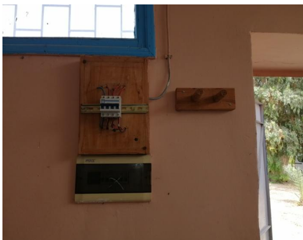
Figure 61 : Interrupteur différentiel et disjoncteur non couverts.
