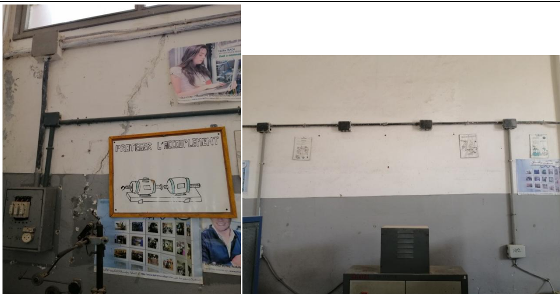
Figure 66 et 67 : Câbles électrique non encastré passant dans un tube avec des boites de dérivation.
