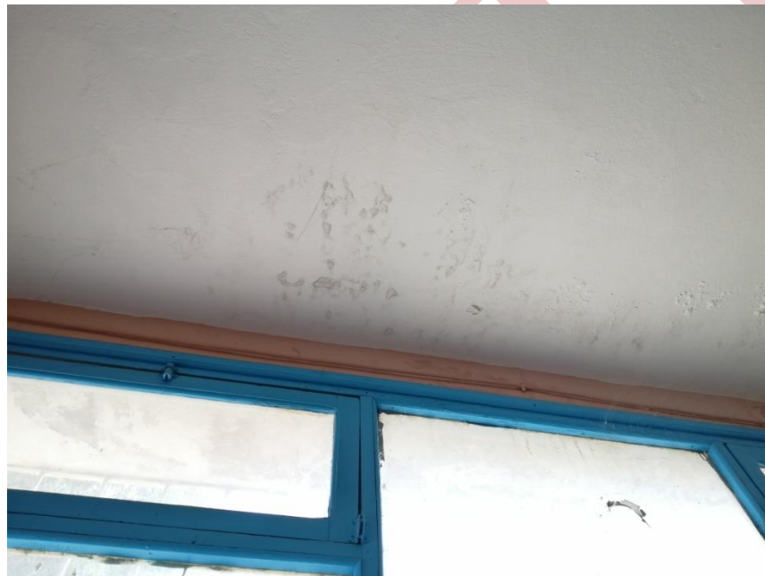
Figure 3 : Traces d'humidité au niveau la dalle, écaillage de la peinture.
