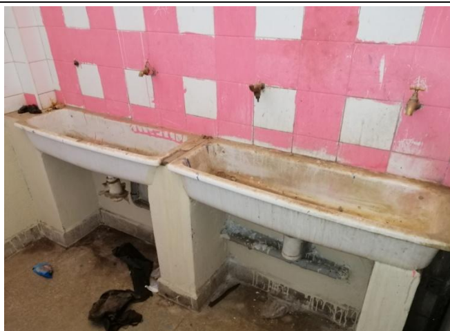
Figure 73 : Robinetterie non fonctionnel.
