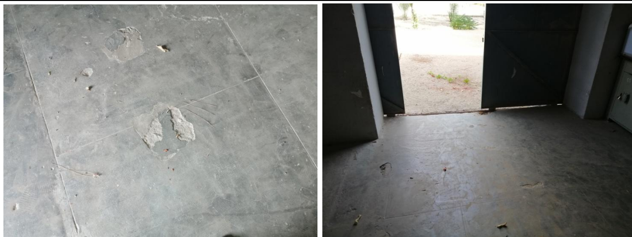
Figure 17 et 18 : Dégradation dallage.
