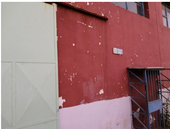
Figure 21 et 22 : Apparition des traces d'humidité et écaillage de la peinture.
