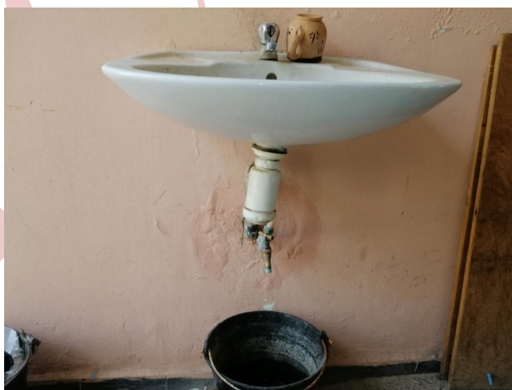
Figure 62 : Fuite au niveau d'assemblage d'assainissement.
