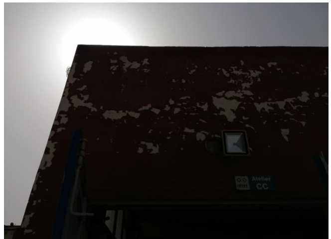
Figure 1 et 2 : Ecaillage de la peinture.
