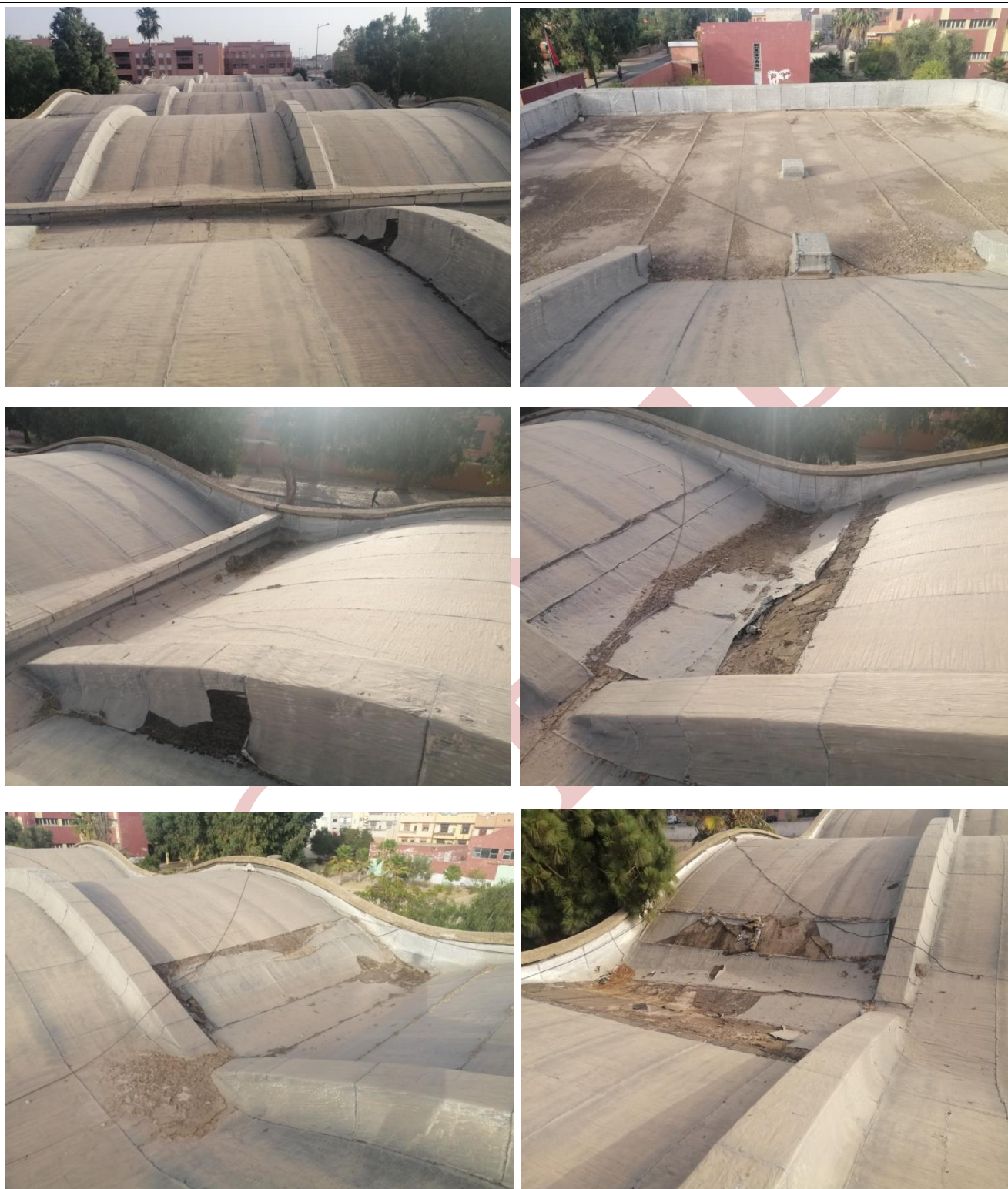
Figure 38, 39, 40, 41, 42 et 43 : Etanchéité des ateliers.
