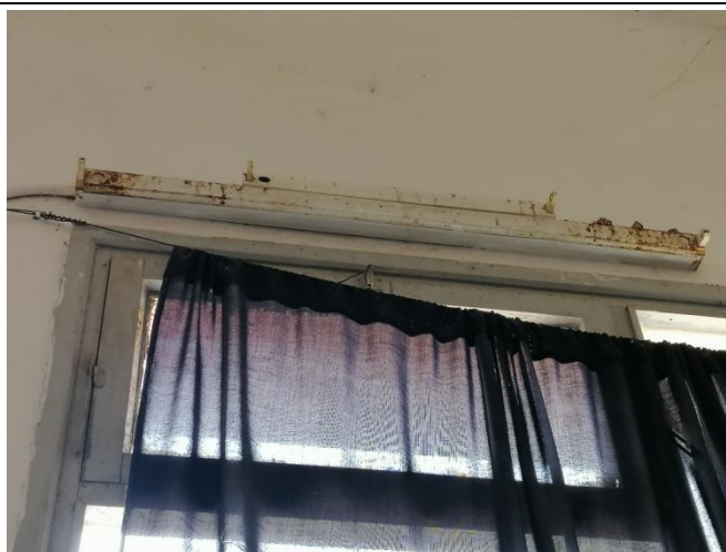
Figure 70 : Lampe LED endommagé.
