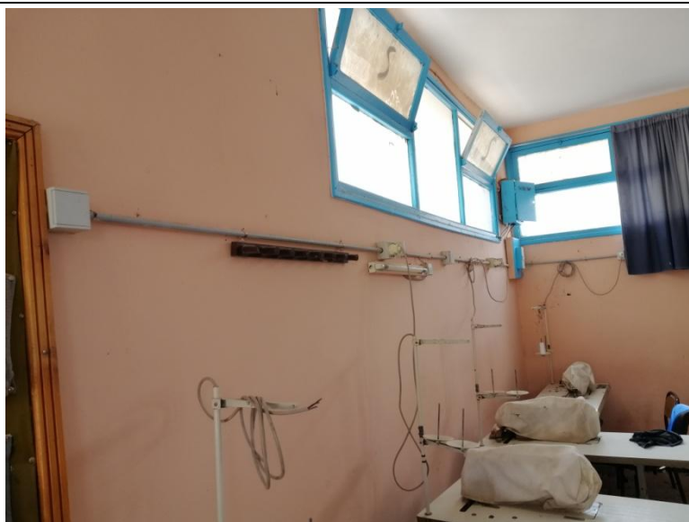
Figure 63 : Câbles électrique non encastré passant dans un tube.
