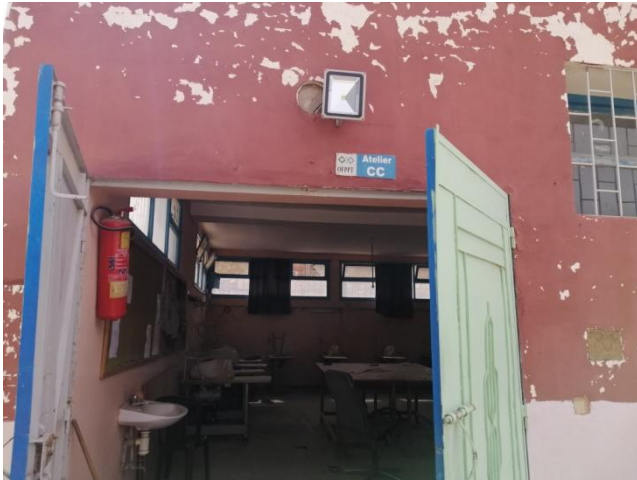
Figure 1 et 2 : Ecaillage de la peinture.
