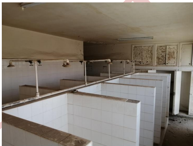
Figure 89, 90 et 91 : Robinetterie non fonctionnels.
