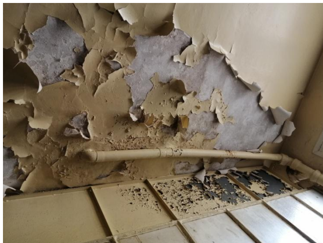
Figure 35 et 36 : Apparition des traces d'humidité et écaillage de la peinture.
