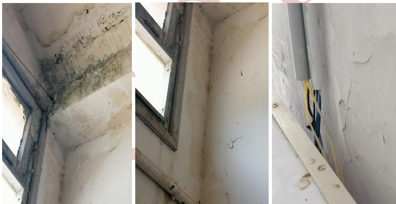
Figure 14, 15 et 16: Apparition des traces d'humidité et écaillage de la peinture.
