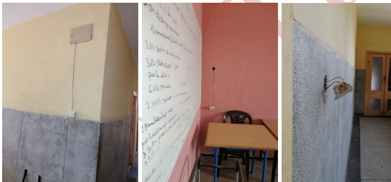
Figure 85, 86 et 87 : Câble électrique non isolés.
