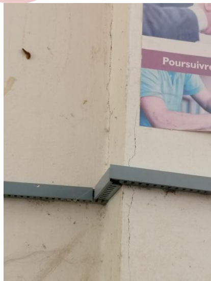
Figure 7, 8, 9 et 10 : Apparition des fissurations.
