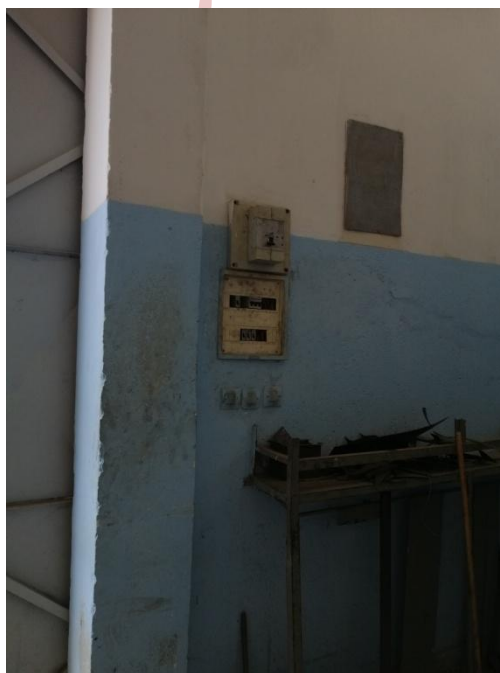
Figure 72 : Coffret des interrupteurs différentiel non couvert.
