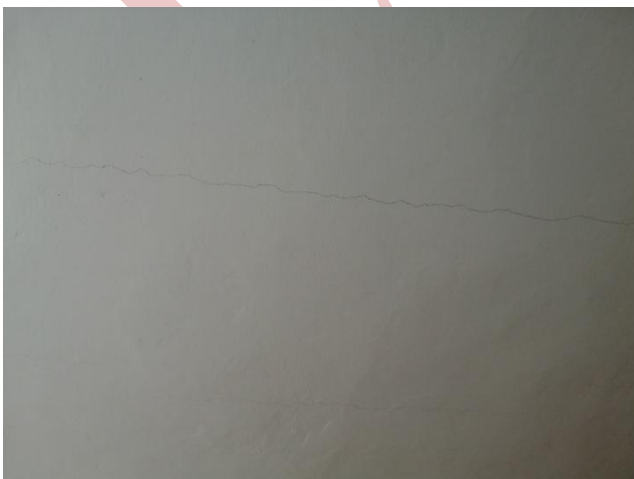
Figure 4 et 5 : Apparition des fissurations verticale au niveau des enduits.
