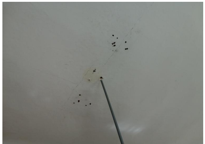
Figure 4 et 5 : Apparition des fissurations verticale au niveau des enduits.
