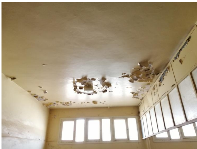
Figure 35 et 36 : Apparition des traces d'humidité et écaillage de la peinture.
