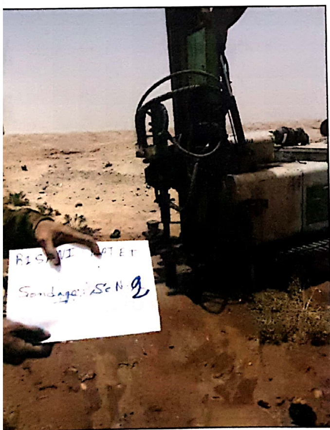
Photo N°5 et 6: Montrant l'exécution du sondage carotté SC2
