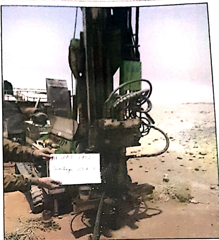
Photo N°4: Montrant l'exécution du sondage carotté SC1
