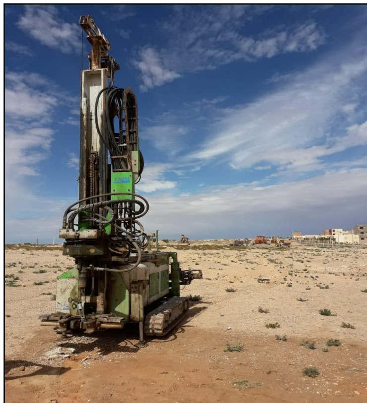
Photo N° 5 et 6: Montrant l'exécution du sondage carotté SC1
