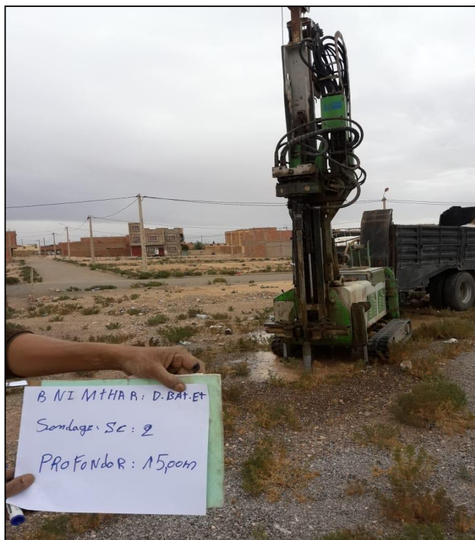
Photo N° 7 et 8: Montrant l'exécution du sondage carotté SC2
