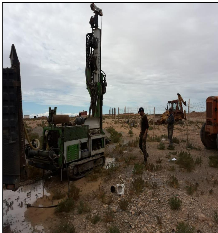
Photo N° 7 et 8: Montrant l'exécution du sondage carotté SC2
